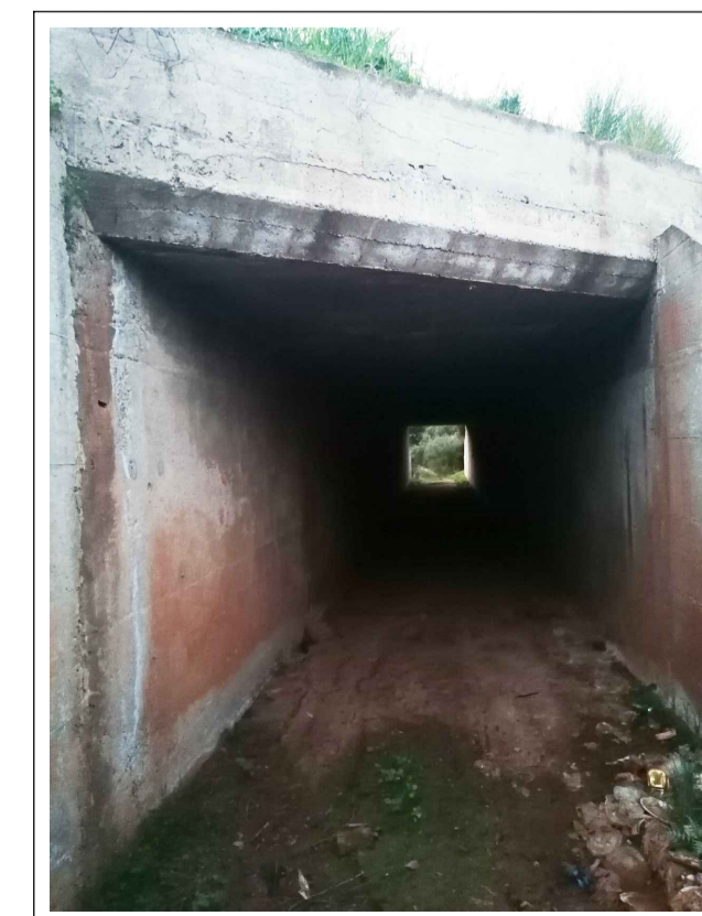
IMBOCCO LATO EST
