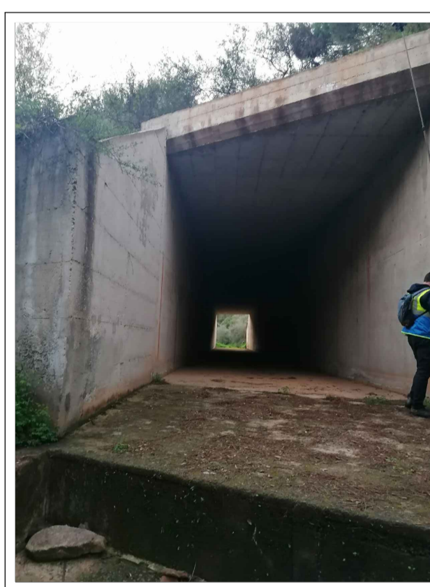
IMBOCCO LATO EST
