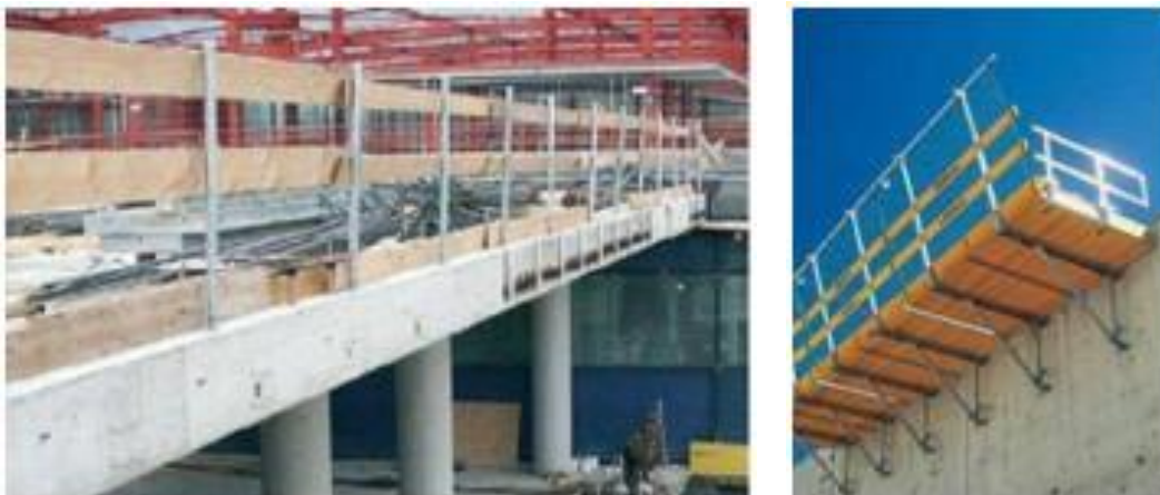
Figura 9– Esempi di protezioni alla caduta dall'alto
