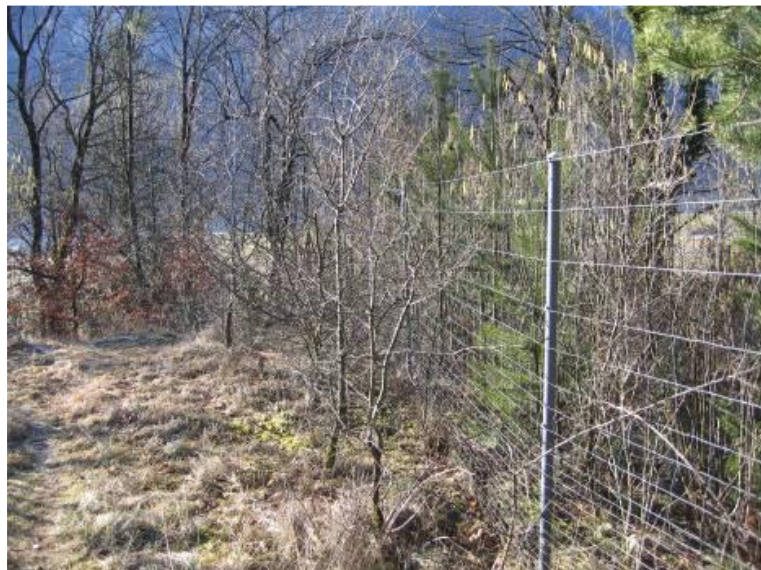
Figura 7-2 Esempio di recinzione anti fauna.
