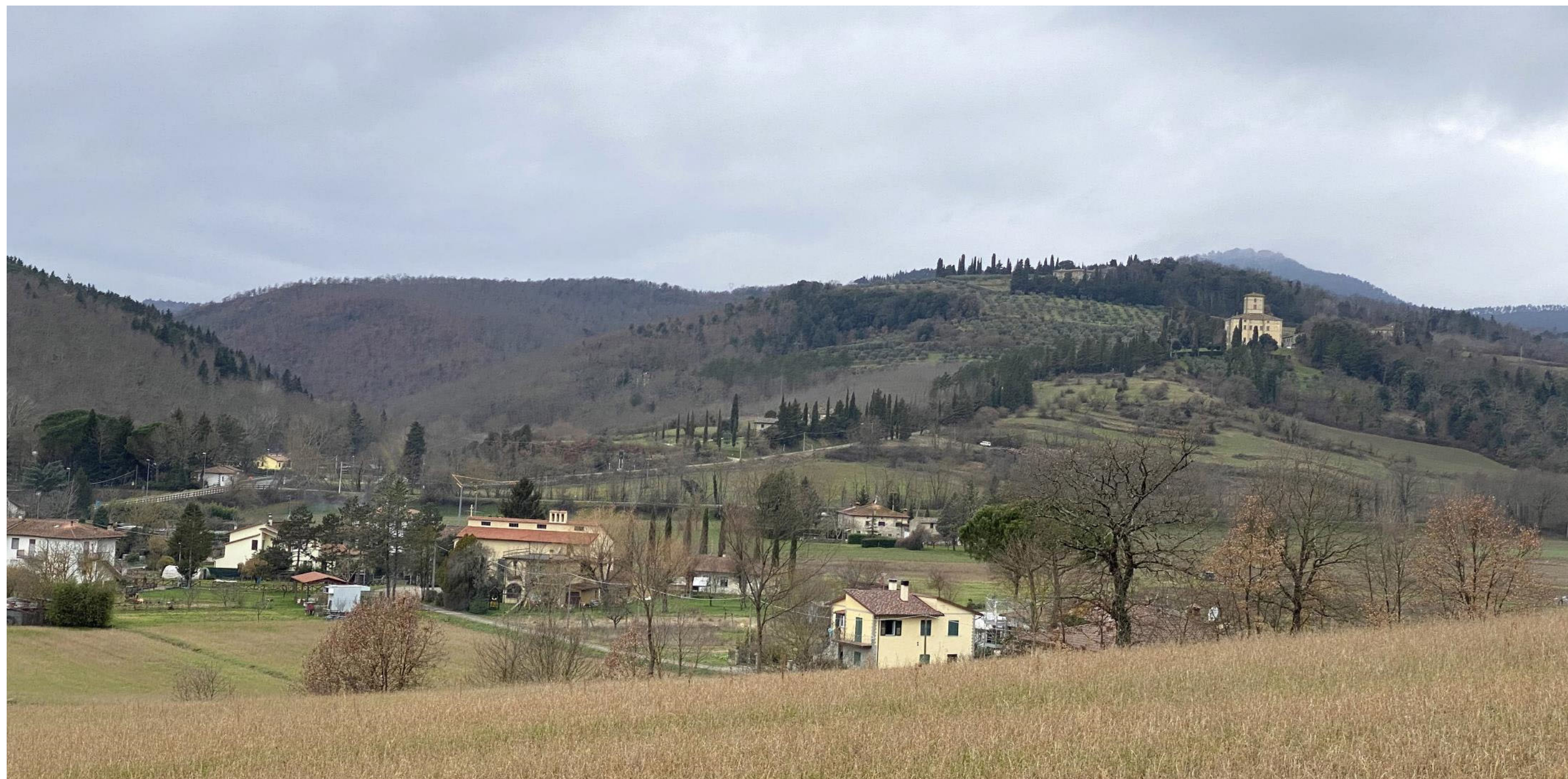
Panoramica dal punto di visuale 1 successivamente alla realizzazione dei ripristini ambientali
