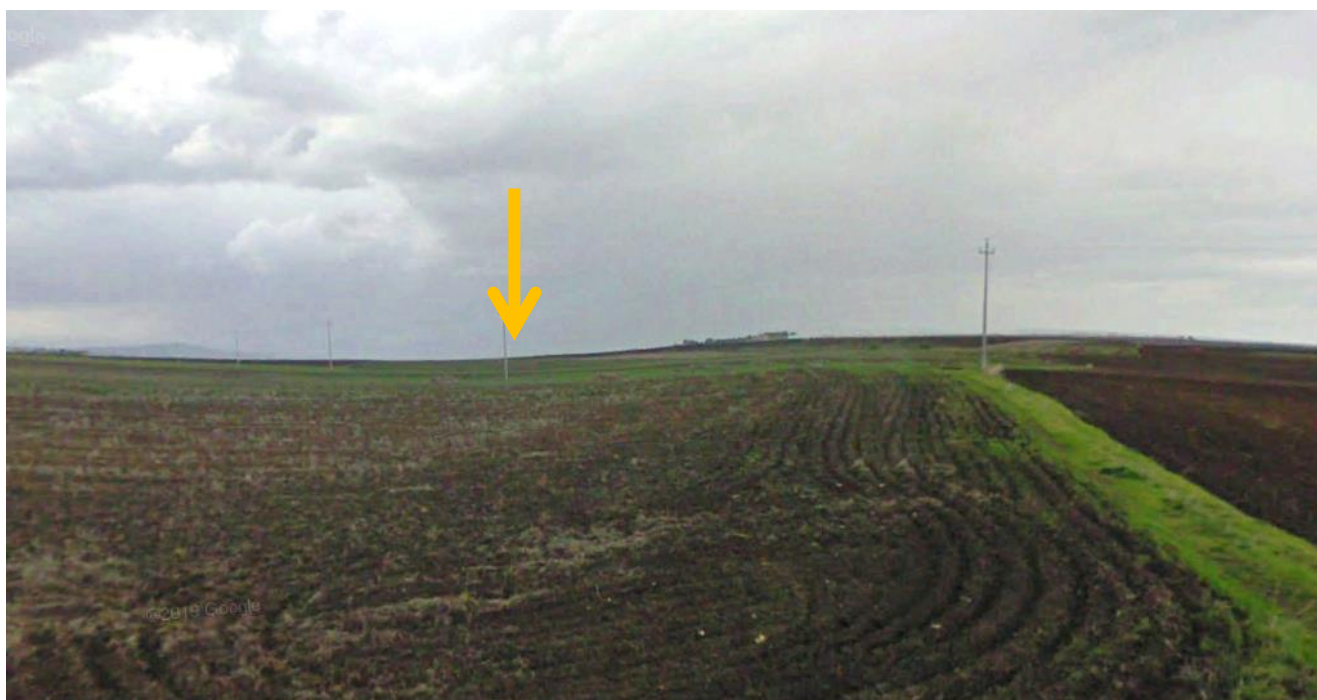
Figura 2-8: Vista turbina WTG 5
