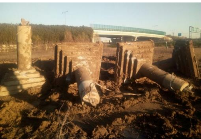
Figura 5.19: Esempio di rimozione della fondazione superficiale si sostegni.
