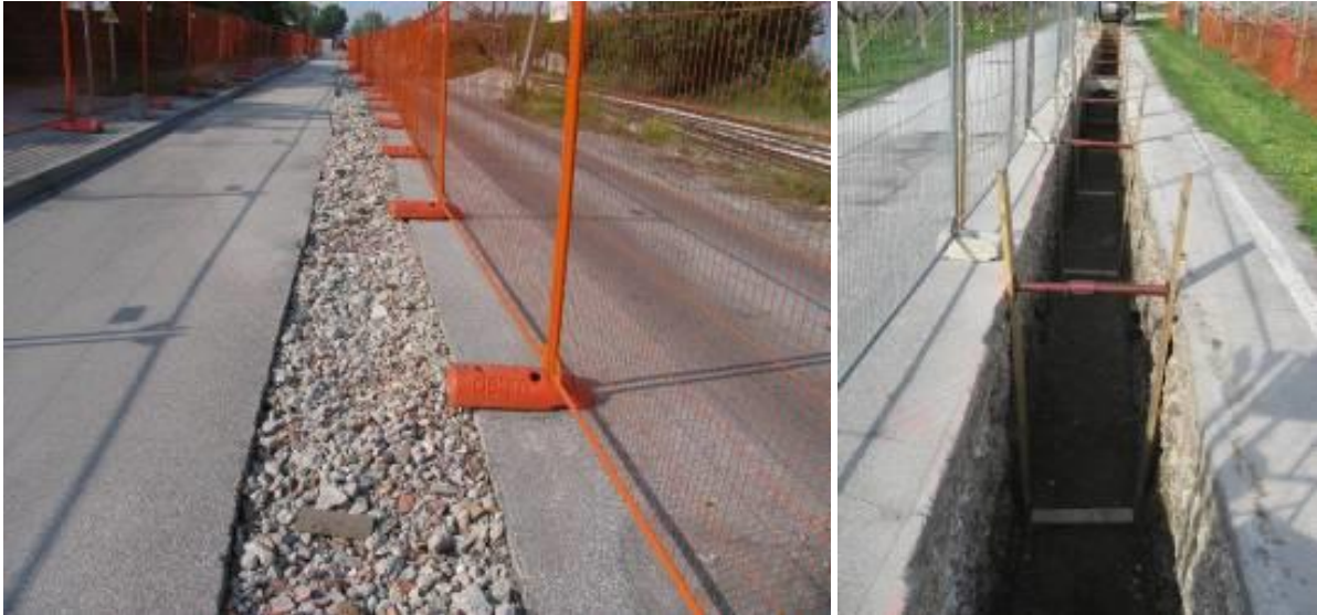
Figura 5.8: Taglio dell'asfaltatura e scavo aperto
