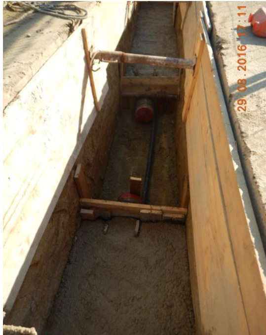
Figura 5.11: Installazione dei cavi HVDC
