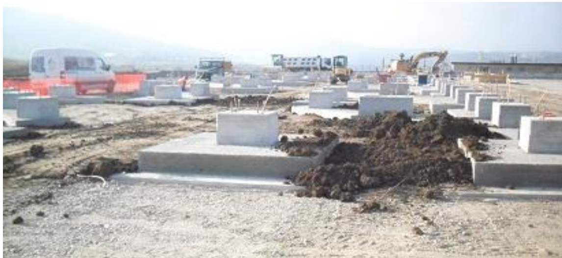
Figura 5.1: Fondazioni apparecchiature unipolari
