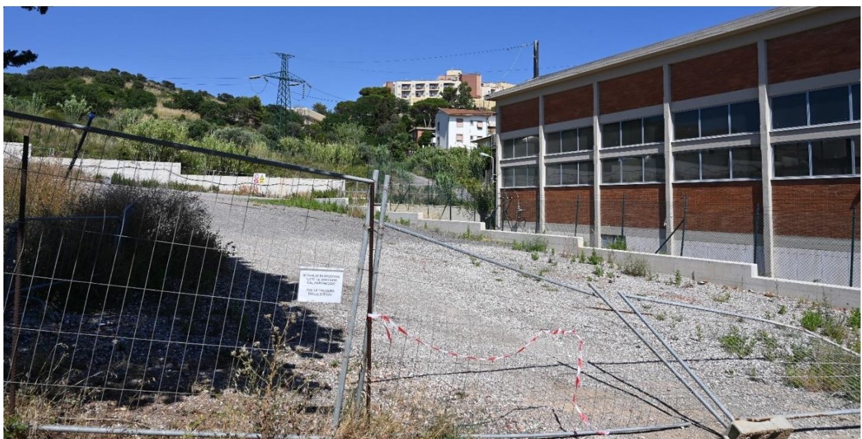
Figura 4.11: Vista dell'area destinata al cantiere del punto di transizione dell'intervento (E)
