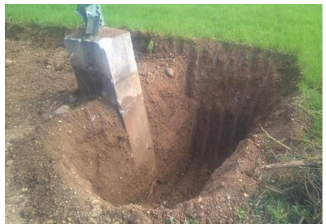
Figura 5.19: Esempio di rimozione della fondazione superficiale si sostegni.
