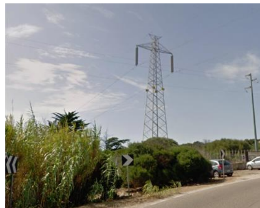
Figura 2.13: Intervento B: esempio di sostegni esistenti del SA.CO.I. 2 oggetto di dismissione attraverso gli interventi di demolizione
