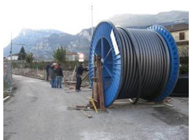
Figura 5.9: Esempi di posizionamento della bobina contenente il cavo
