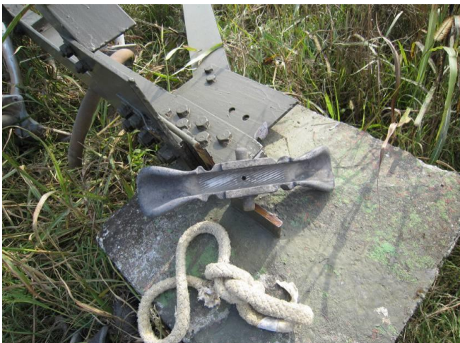
Figura 5.18: Fasi di demolizione di un sostegno a traliccio, particolare di materiale raccolto
