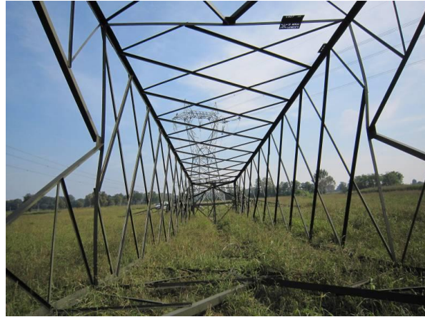
Figura 5.17: Fasi di demolizione di un sostegno a traliccio
