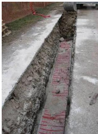
Figura 5.10: Rinterro con posa delle piastre di protezione e rete in PVC
