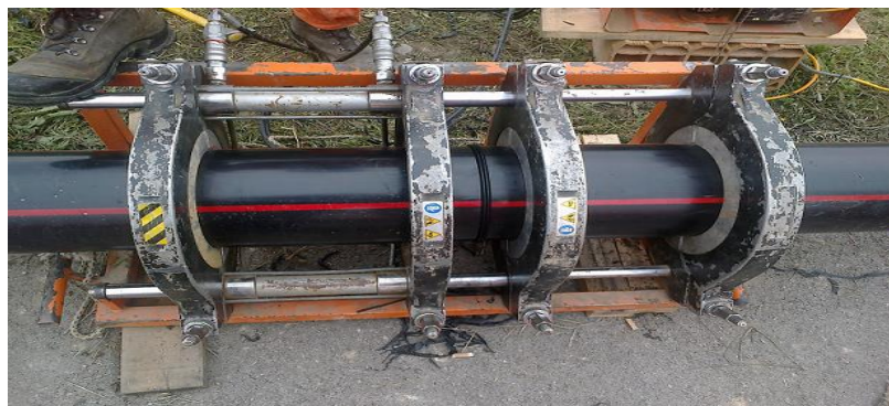
Figura 5.13: Particolare saldatura tubazioni PEAD
