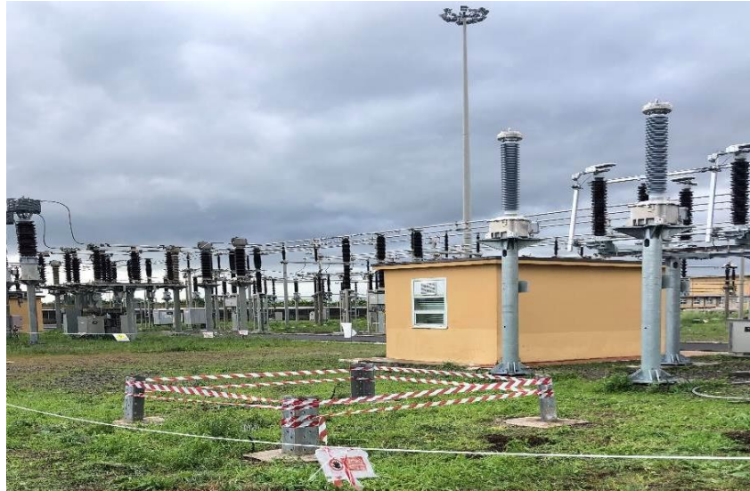
Figura 5.20: Esempio di rimozione sostegni di stazione (palo gatto)
