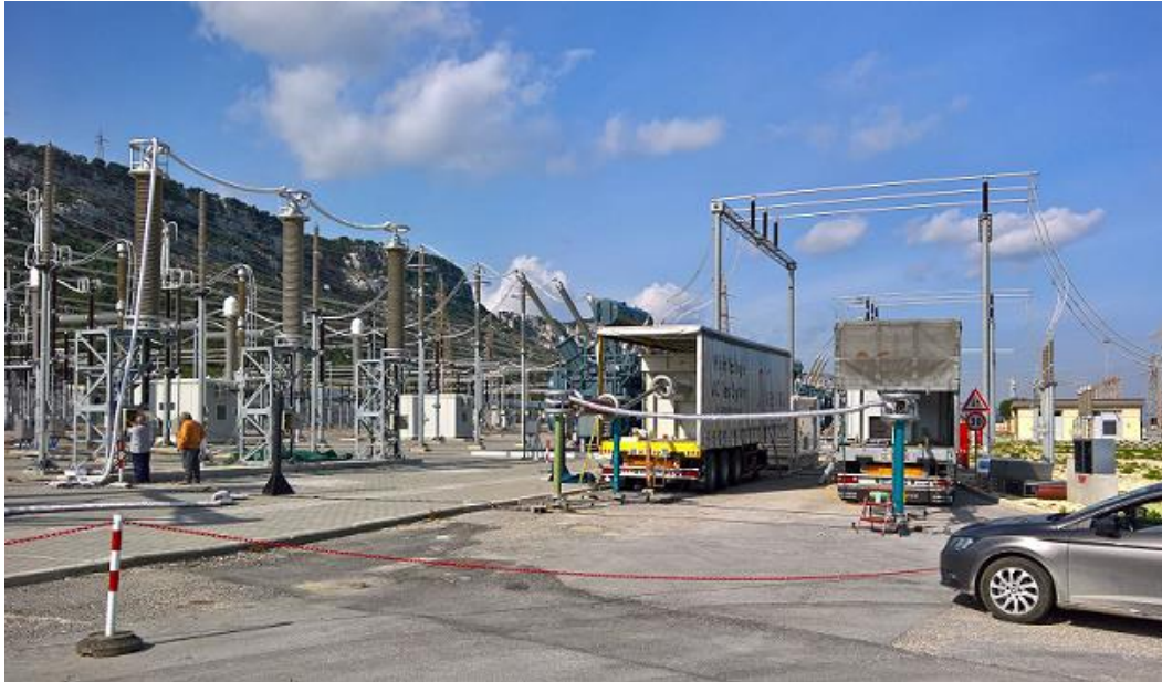
Figura 5.16: Esempio di collaudo per un collegamento HVAC
