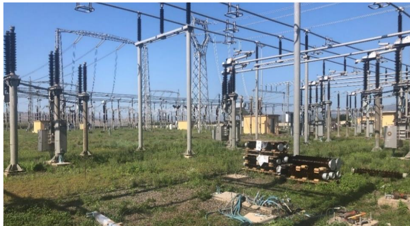
Figura 5.21: Esempio smontaggi apparecchiature AT
