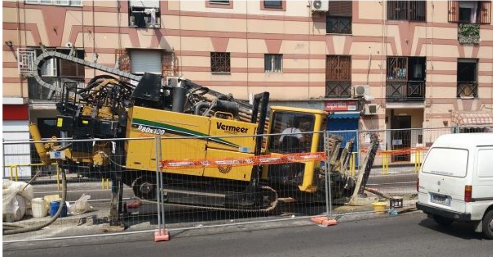
Figura 5.14: Macchina Operatrice per esecuzione TOC
