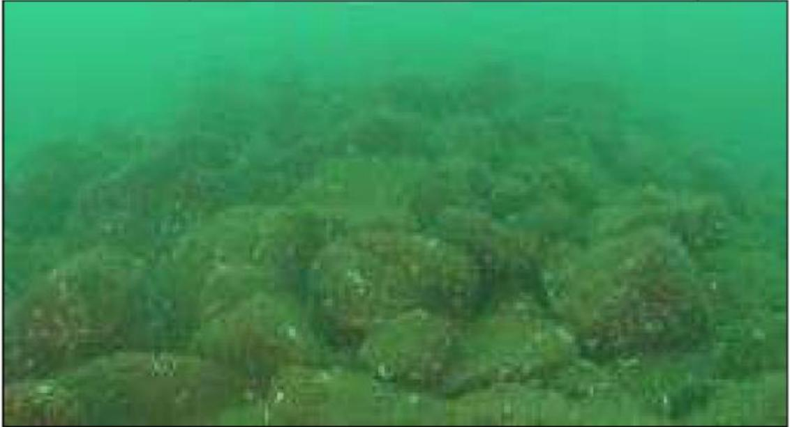
Figura 5.16: Esempio di ricopertura di un cavo con rock dumping
