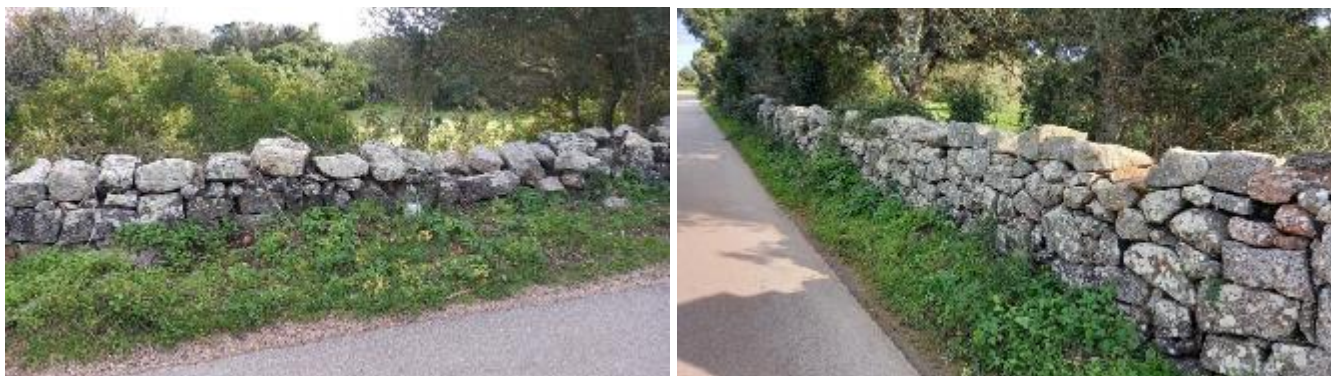
Figura 7.22: Esempi di muretti a secco riscontrabili lungo il tracciato di progetto
