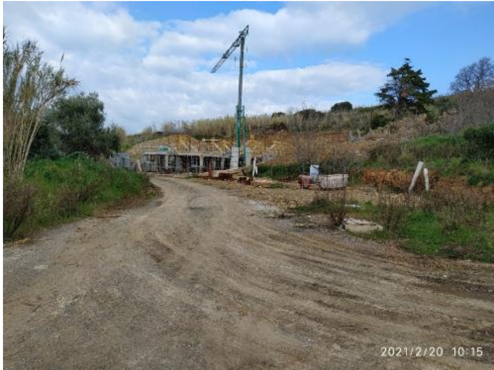
Figura 4.49: Altro sbancamento significativo a monte dell'edificio in costruzione.
