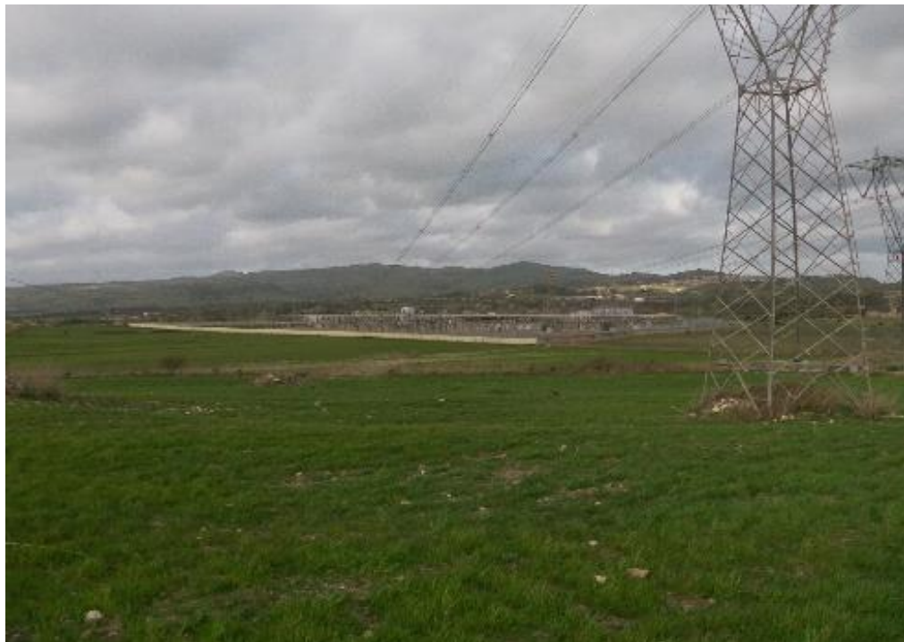
Figura 10.23: Ripresa fotografica Punto di vista 6
