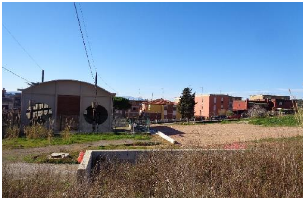
Figura 10.102: Ripresa fotografica Punto di vista 10
