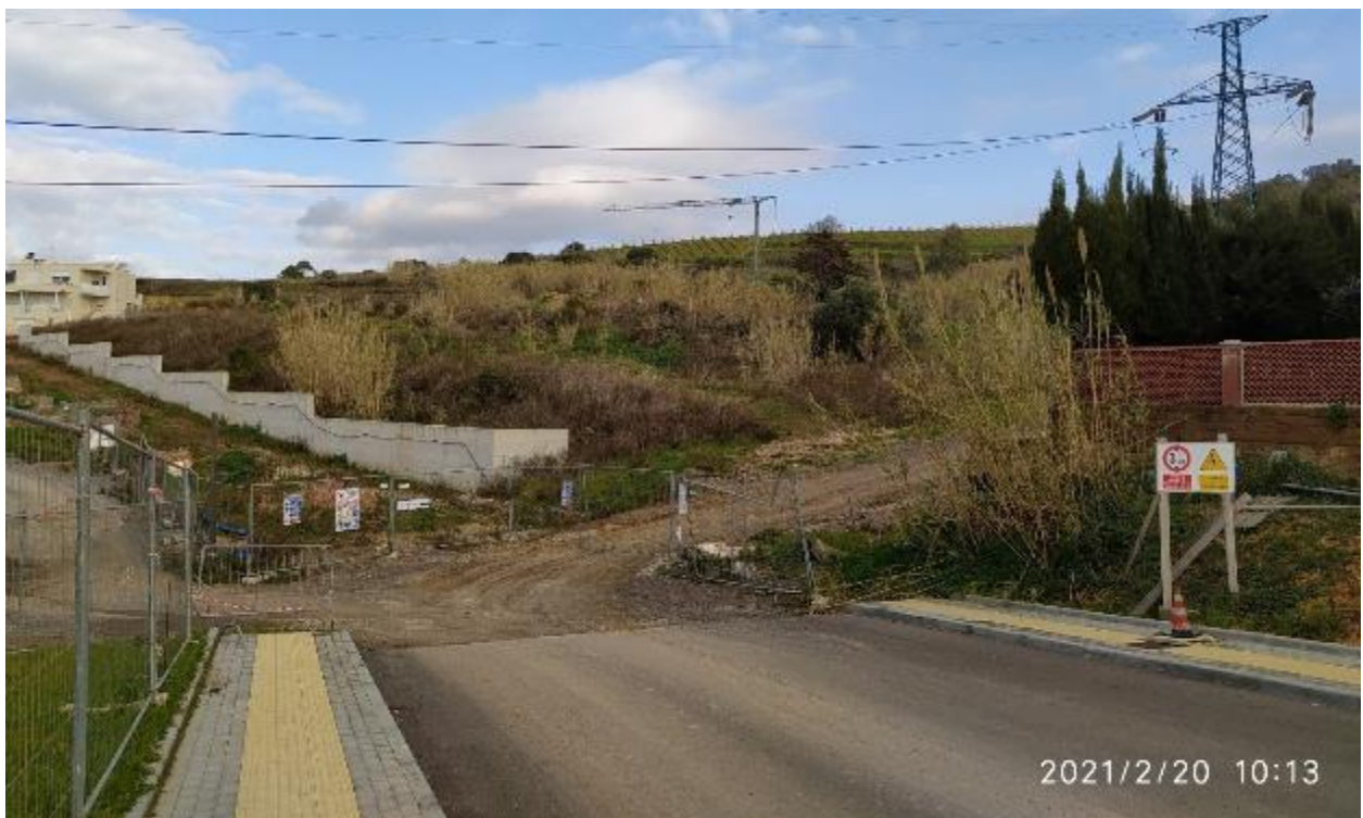
Figura 4.50: Sbancamento al piede del versante contenuto da pannelli prefabbricati.
