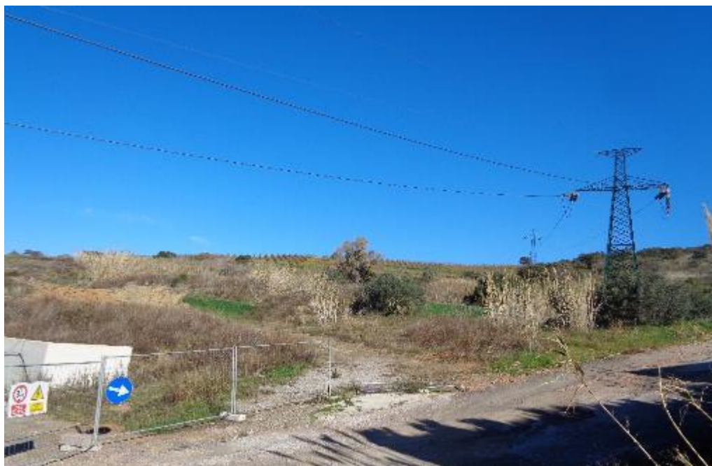
Figura 10.100: Ripresa fotografica Punto di vista 9
