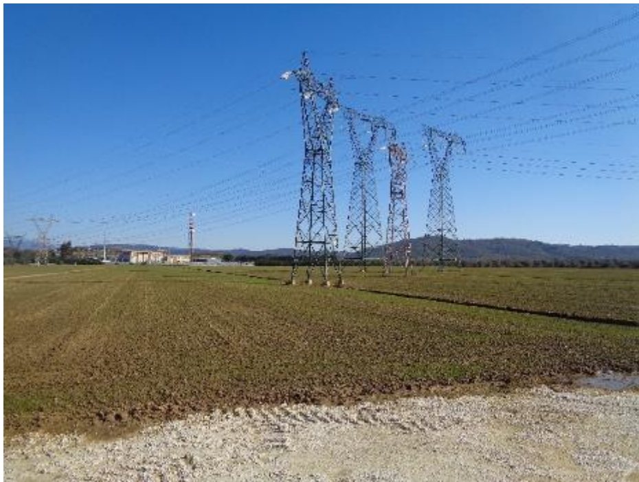
Figura 10.110: Ripresa fotografica Punto di vista 3
