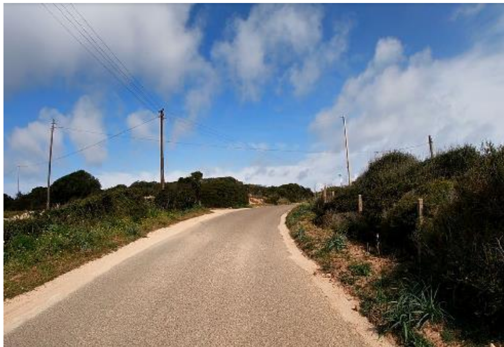
Figura 10.44: Ripresa fotografica Punto di vista 5
