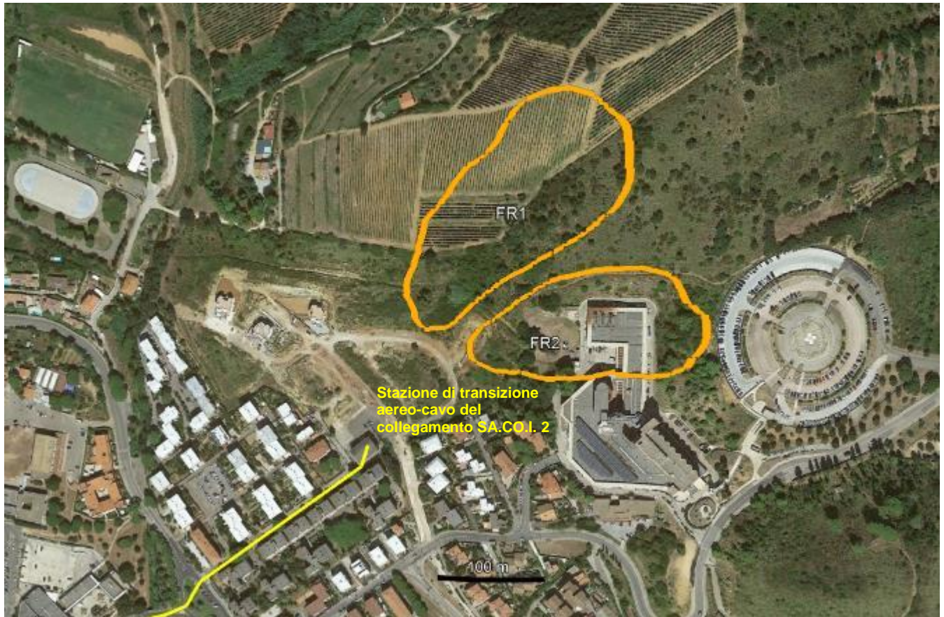
Figura 4.45: Ortofoto che mostra l'ubicazione delle due frane identificate con le sigle FR1 e FR2. La perimetrazione è tratta dal Piano di bacino del distretto idrografico dell'Appennino Settentrionale, stralcio Assetto Idrogeologico per la gestione del rischio da dissesti di natura geomorfologica. In giallo è rappresentato il tratto terminale del cavidotto in progetto.
