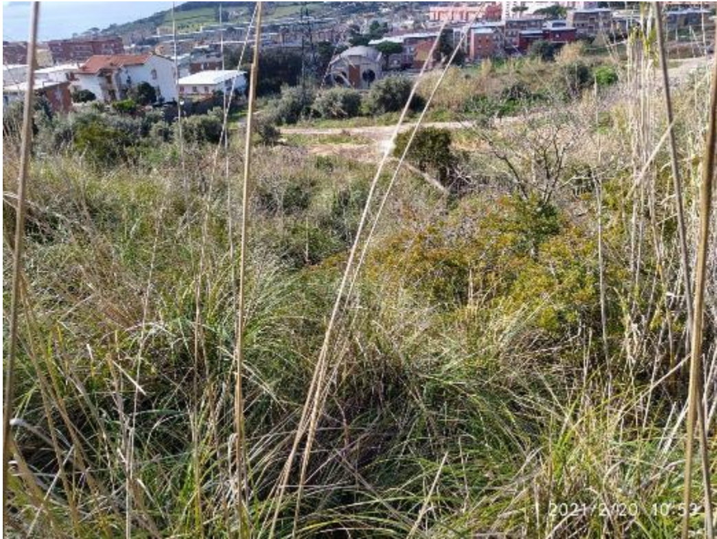
Figura 4.52: L'area di frana ripresa dal ciglio superiore. Sullo sfondo si vede il fabbricato del punto di transizione di SA.CO.I. 2.
