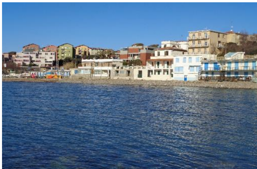
Figura 10.84: Ripresa fotografica Punto di vista 1
