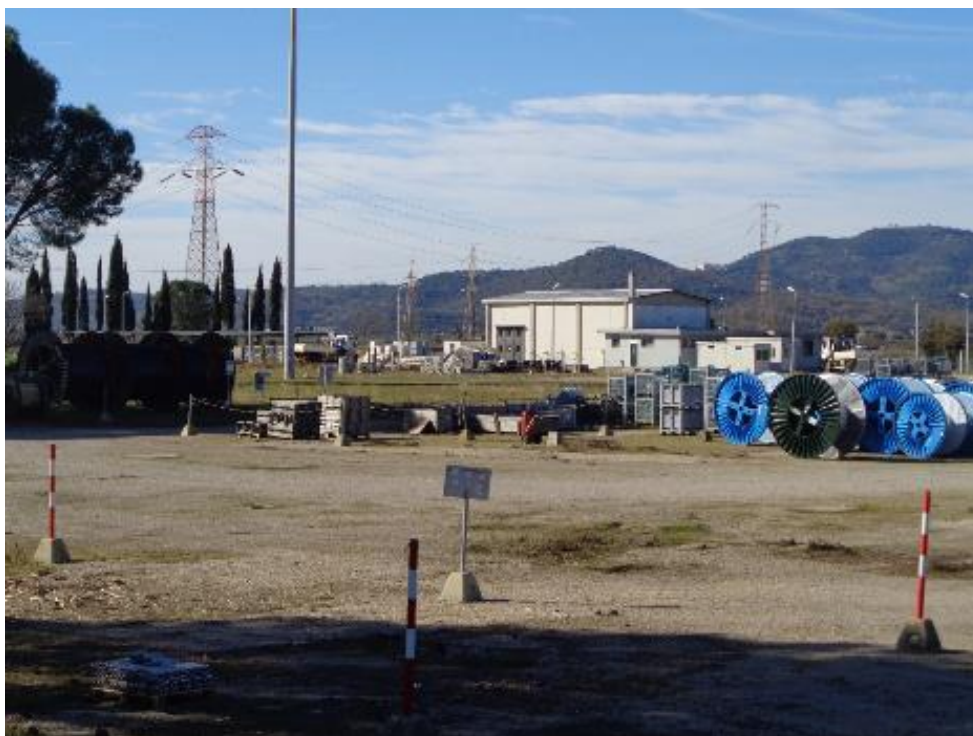
Figura 10.122: Ripresa fotografica Punto di vista 9
