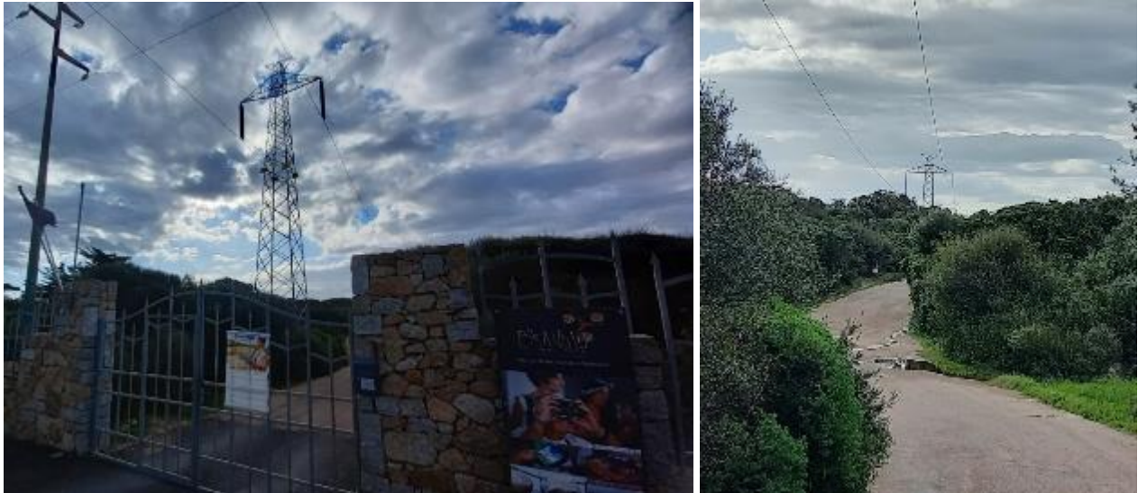
Figura 10.61: Foto tralicci 6 e 7
