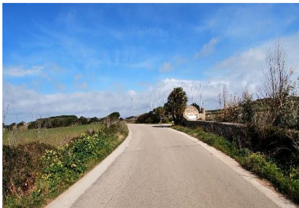
Figura 10.48: Ripresa fotografica Punto di vista 7
