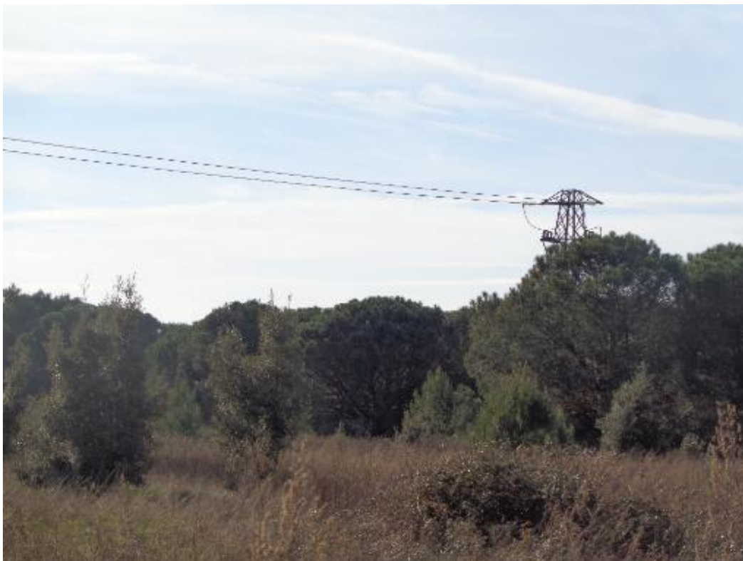
Figura 10.144: Ripresa fotografica Punto di vista 9
