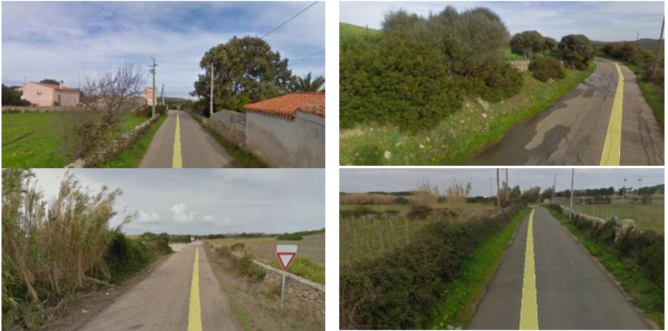
Figura 7.16: Riprese fotografiche della strada interessata dal tracciato dei cavi in progetto
