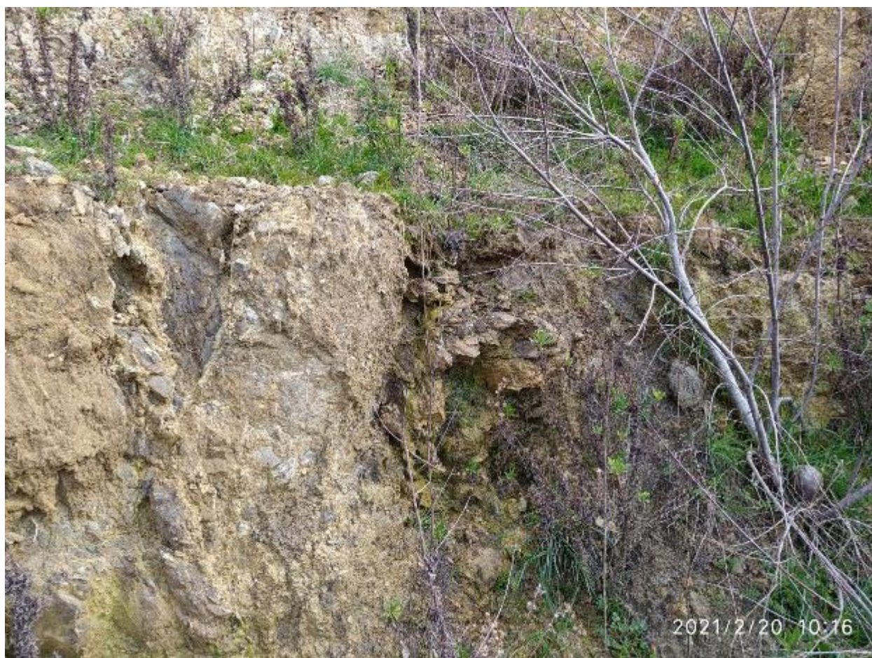
Figura 3.4: Sbancamento del versante a nord del punto di transizione di Salivoli, con piccola venuta sorgentizia.
