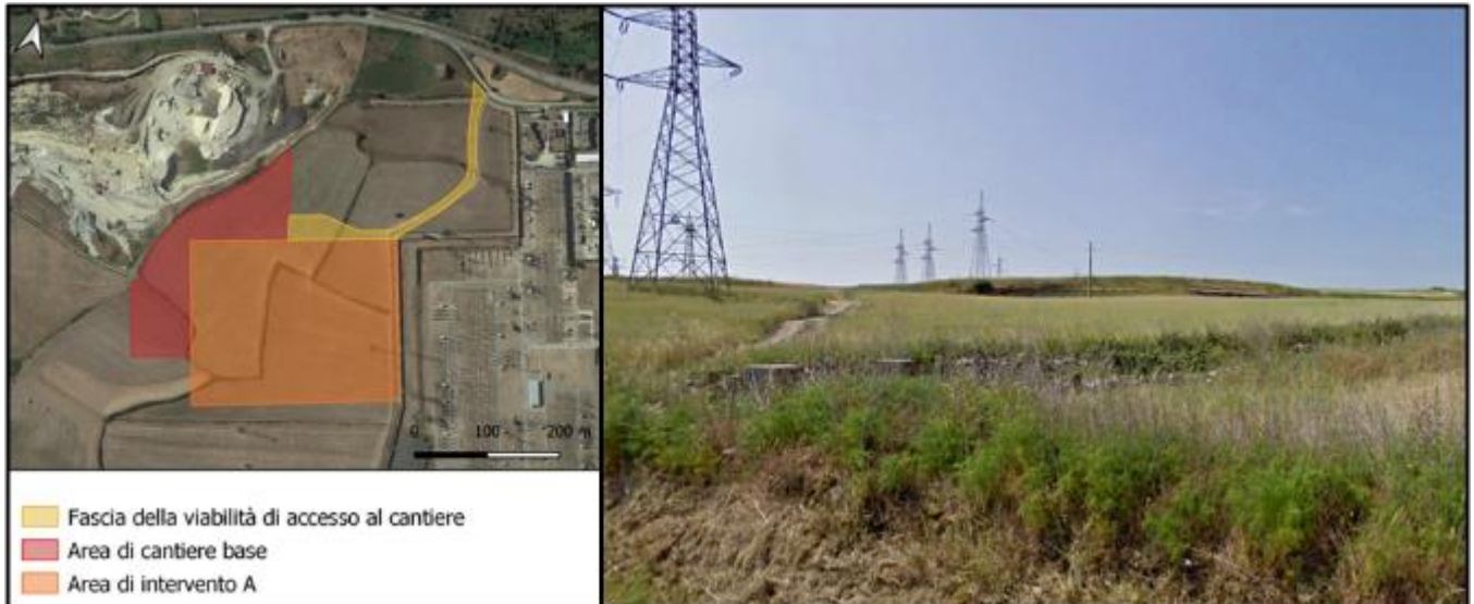
Figura 8.8: Area di cantiere base dell'intervento (A)
