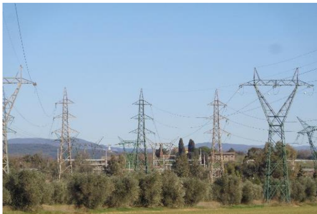
Figura 10.112: Ripresa fotografica Punto di vista 4
