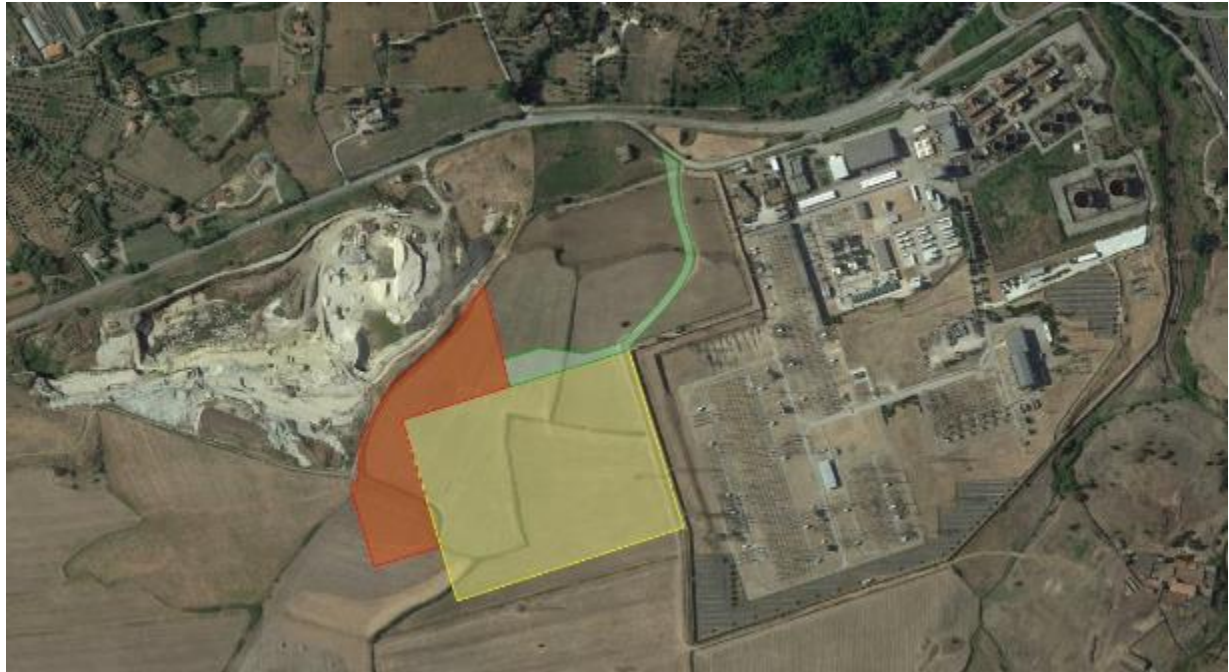
Figura 11.10: Area di cantiere (in rosso) ed area di lavoro (in giallo) per la realizzazione della nuova stazione elettrica di conversione di Codrongianos
