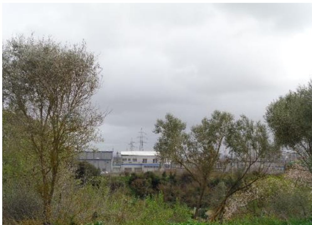
Figura 10.29: Ripresa fotografica Punto di vista 9
