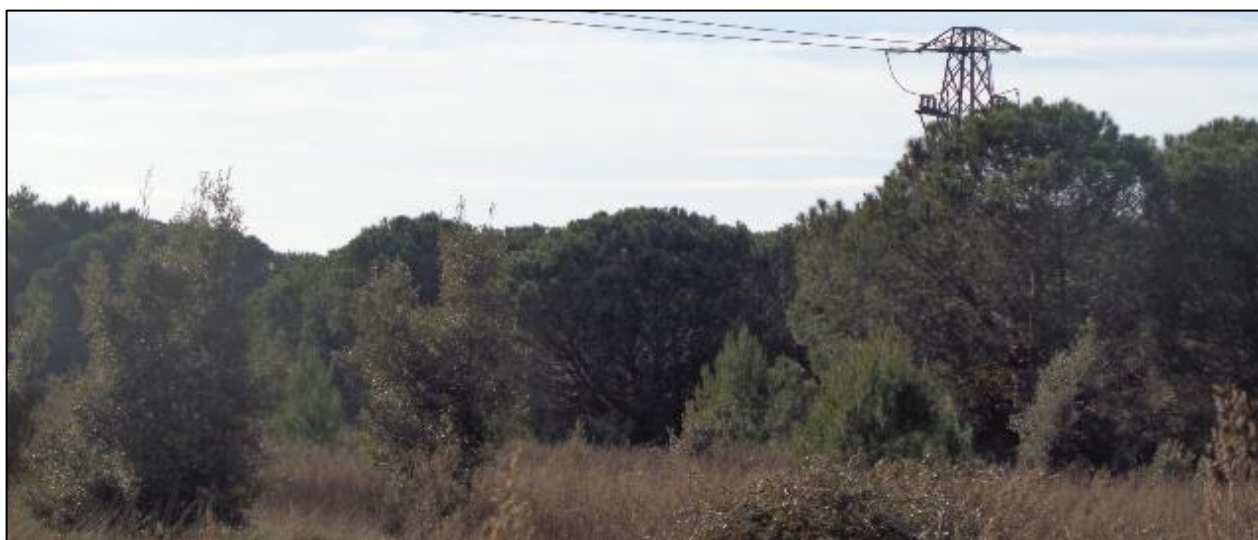
Figura 8.32: Ex-Frutteto abbandonato interessato dall'intervento Catodo e relativi cavi di elettrodo (G)
