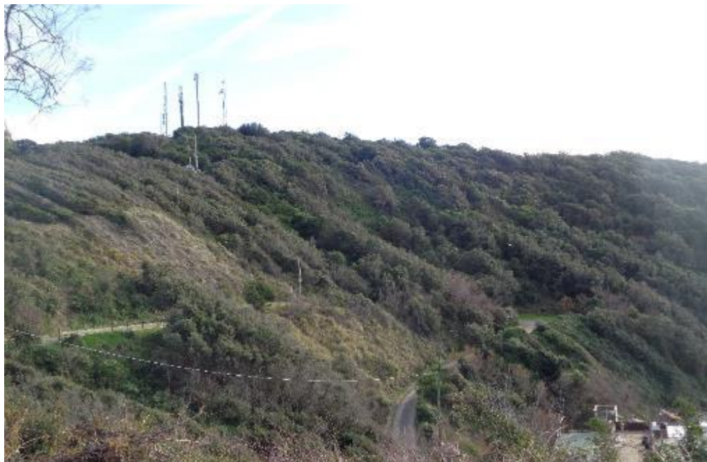
Figura 10.98: Ripresa fotografica Punto di vista 8
