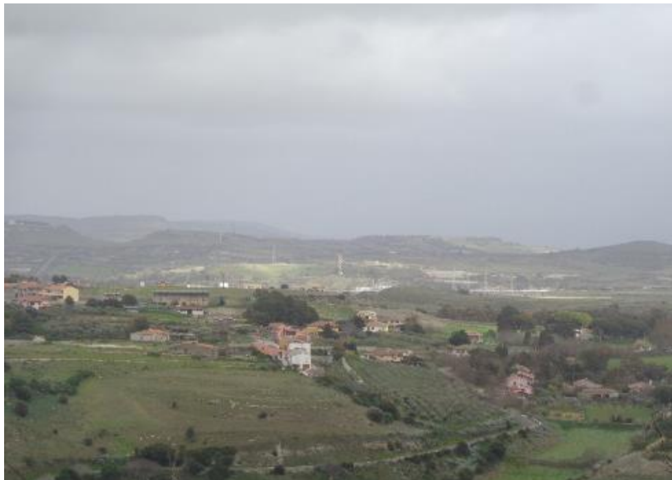
Figura 10.31: Ripresa fotografica Punto di vista 10
