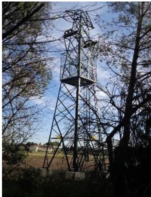
Figura 10.146: Ripresa fotografica Punto di vista 10
