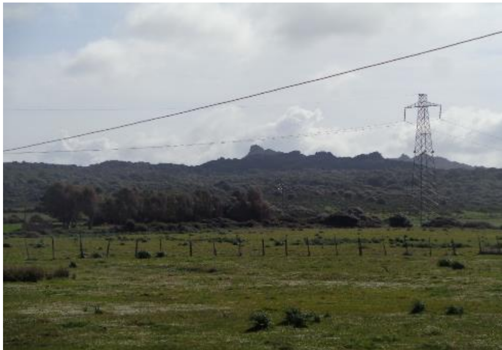
Figura 10.52: Ripresa fotografica Punto di vista 9
