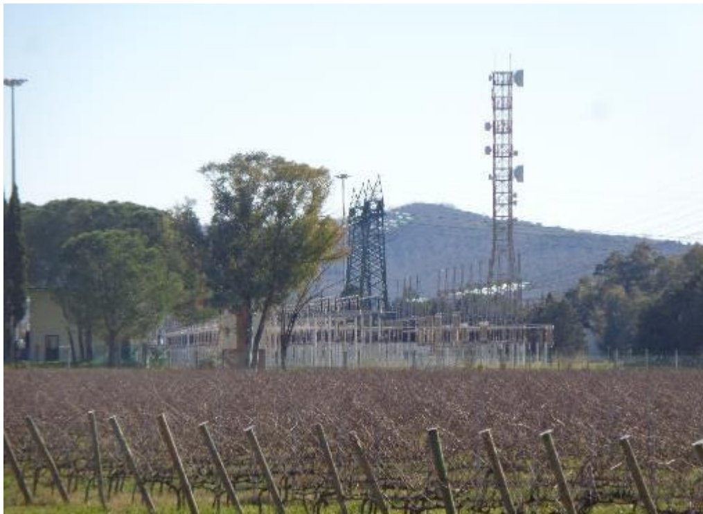
Figura 10.114: Ripresa fotografica Punto di vista 5
