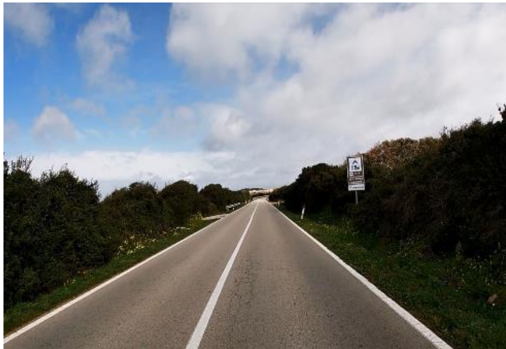
Figura 10.46: Ripresa fotografica Punto di vista 6
