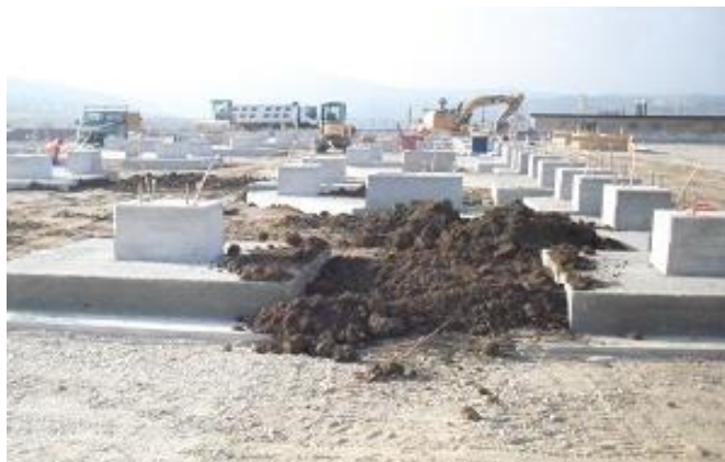
Figura 4.17: Fondazioni apparecchiature unipolari
