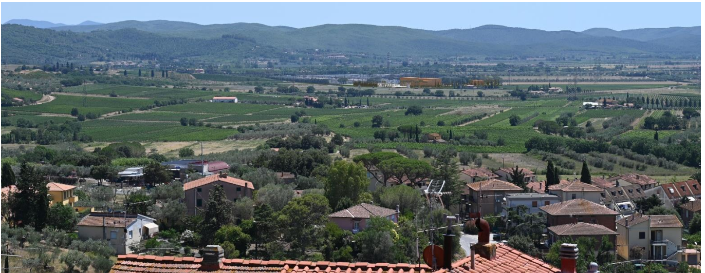
Figura 7.18: Vista dal paese di Suvereto: fotoinserimento della nuova stazione elettrica
