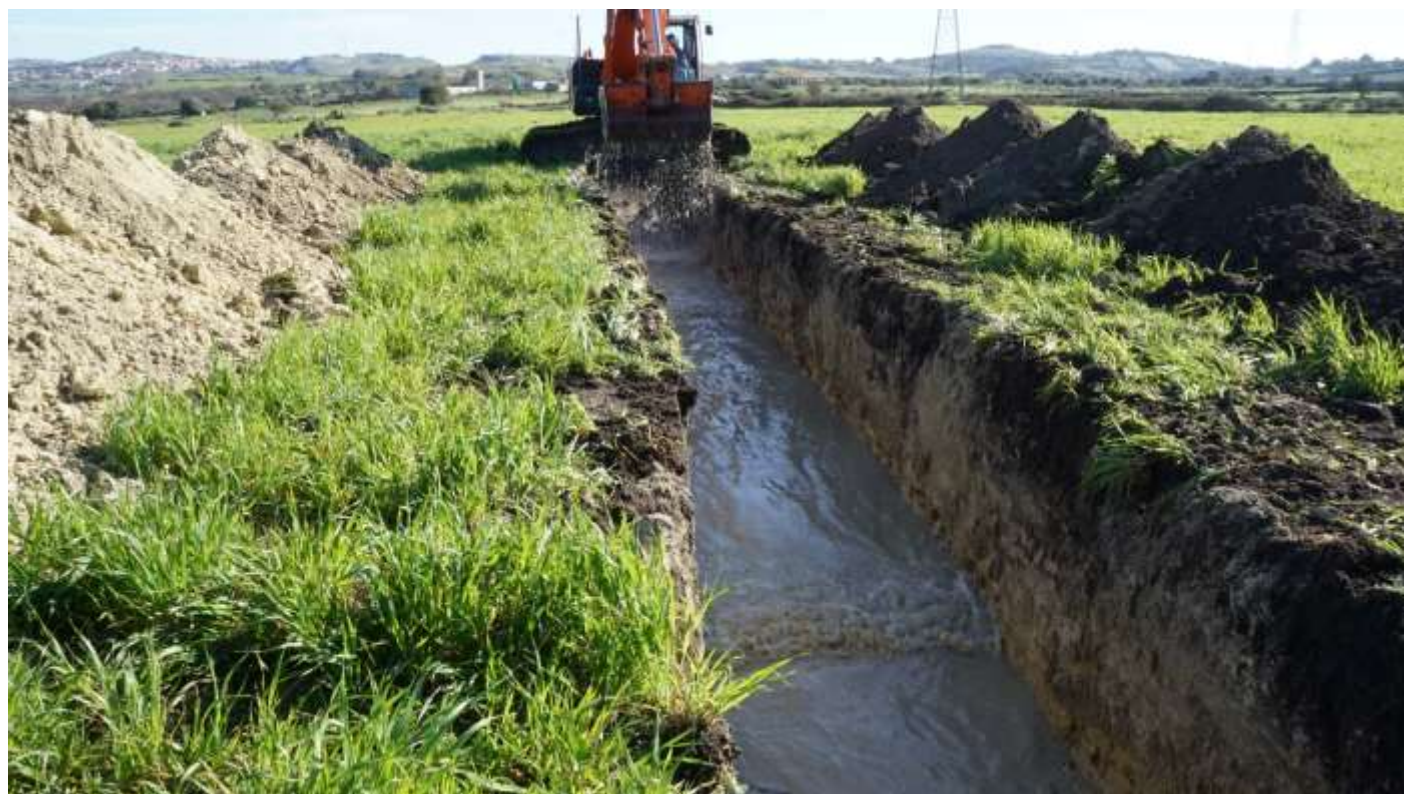
Fig. 4 Operazioni di svuotamento dall'acqua delle trincee prima del reinterro
