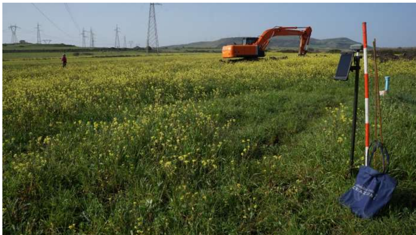
Fig. 79 Operazioni di scavo presso l'alternativa 1
