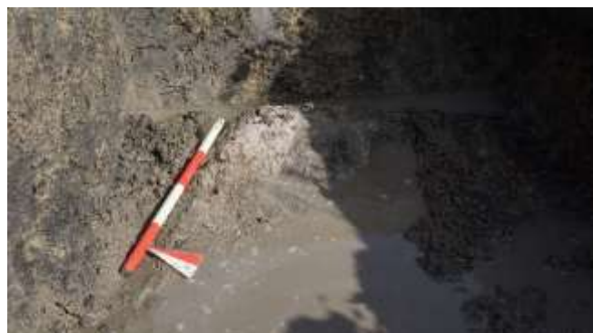
Fig. 109 Trincea 14, blocco di calcestruzzo
