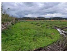
032_STG.TERNA21.BNC_area a fine lavori
