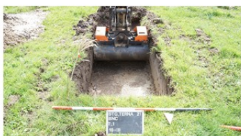
016_STG.TERNA21.BNC_tentativo scavo T1 da N
