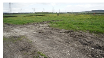
345_CDR.TERNA21.ALT.1_area a fine lavori
