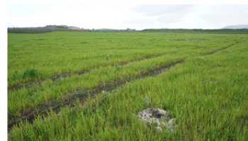
339_CDR.TERNA21.ALT.1_area a fine lavori
