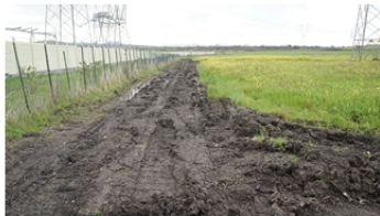
341_CDR.TERNA21.ALT.1_area a fine lavori
