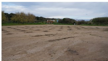
001_STG.TERNA21.MRM_area a inizio lavori
