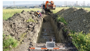
132_CDR.TERNA21.ALT.1_T2 in corso di scavo da SW
