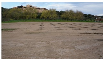
002_STG.TERNA21.MRM_area a inizio lavori
