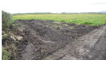
343_CDR.TERNA21.ALT.1_area a fine lavori
