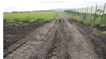
342_CDR.TERNA21.ALT.1_area a fine lavori
