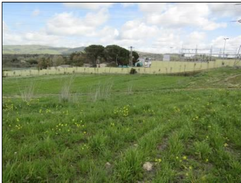
Area investigata, vista della centrale elettrica esistente
