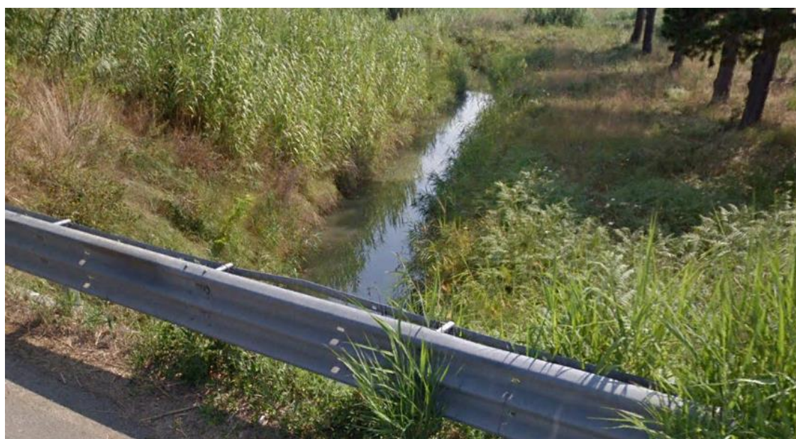
Vista dei due canali (Barnandano orientale e Fossa calda) presenti nell'area
