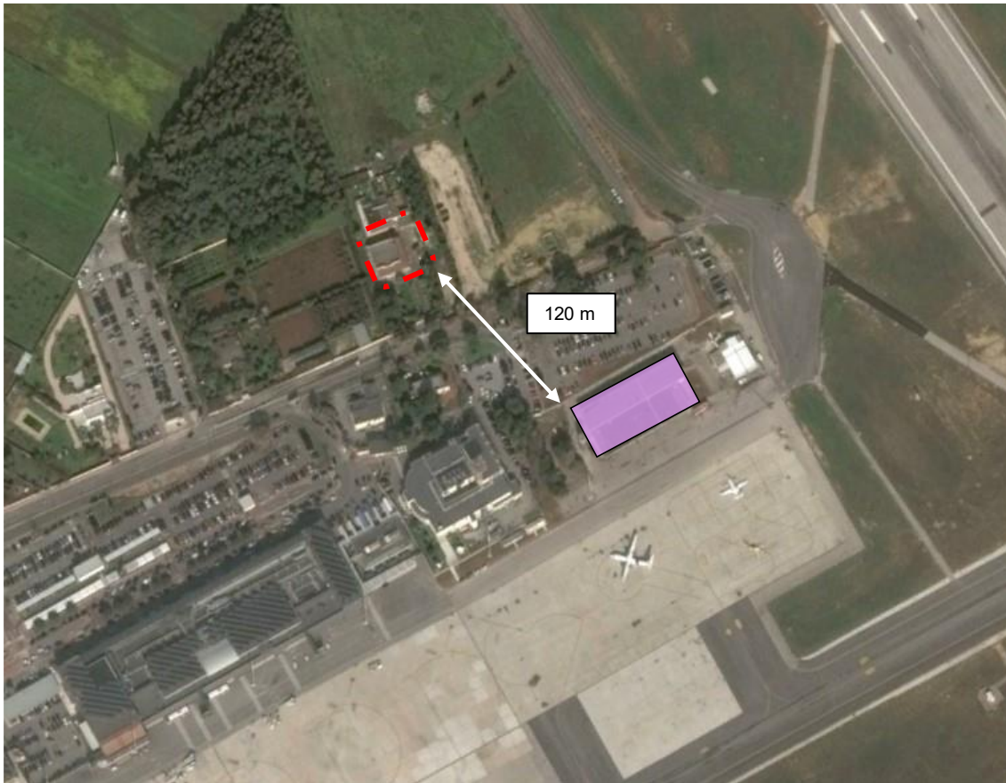
Figura 6-57 Localizzazione di ricettori rispetto le attività previste per la realizzazione del nuovo punto di avvistamento in sopraelevazione
