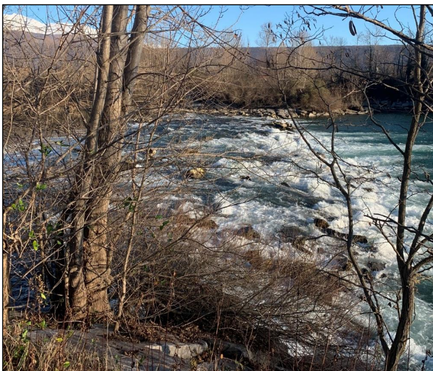
FIGURA 15 – DETTAGLIO BRIGLIA IN MASSI A PROTEZIONE DEL PONTE SS 26
