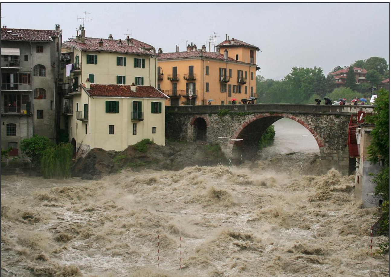
FIGURA 24 – PONTE VECCHIO – REGIME DI PIENA (EVENTO DI PIENA 28 MAGGIO 2008 - \pm 750 \text{ M}^3/\text{S} )
