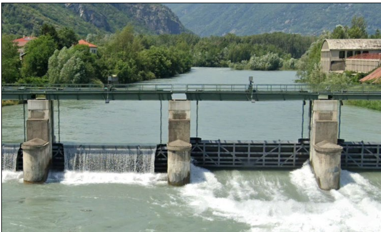
FIGURA 9 – IMPIANTO IDROELETTRICO TORREDANIELE – QUINCINETTO (DORA BALTEA) - LARGHEZZA PARATOIA PIANA ± 12 M
