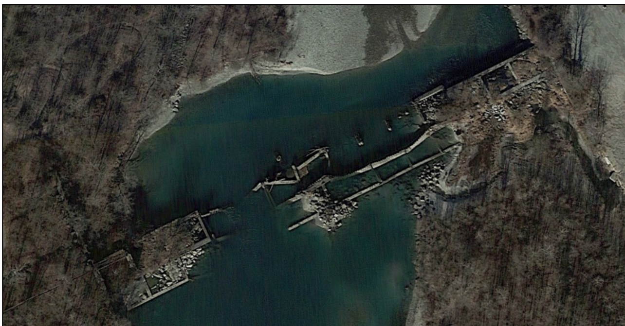
FIGURA 12 – MANUFATTI ESISTENTI – INTERFERENZA CON IL REGIME FLUVIALE (REGIME DI MAGRA)
