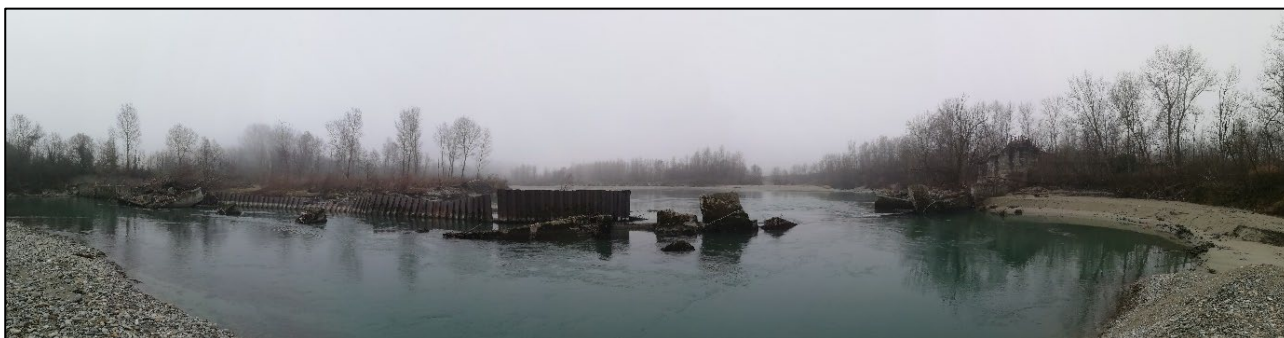
FIGURA 14 – MANUFATTI ESISTENTI – DETTAGLIO VARCO
