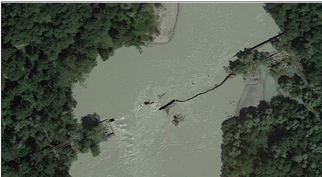
FIGURA 13 – MANUFATTI ESISTENTI – INTERFERENZA CON IL REGIME FLUVIALE (REGIME DI MORBIDA)
