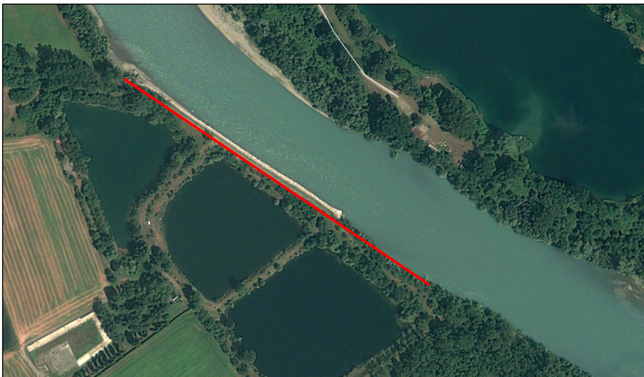
FIGURA 6 – IN ROSSO L'AGGIORNAMENTO DIFESE SPONDALE REALIZZATO DA AIPO NEL 2010 (SPONDA DESTRA)
