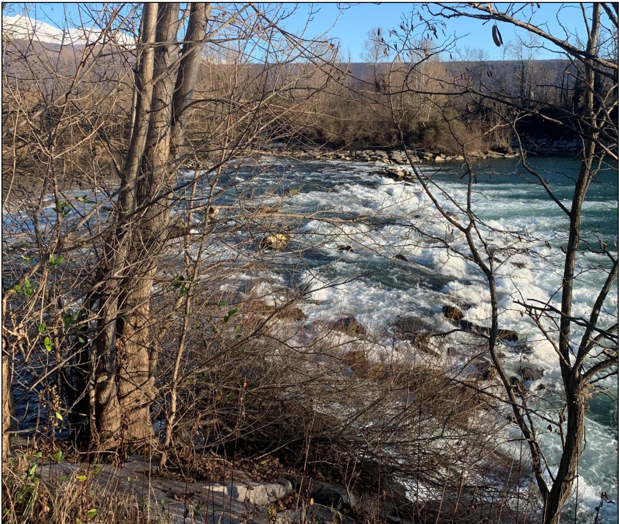
FIGURA 4 – DETTAGLIO BRIGLIA IN MASSI A PROTEZIONE DEL PONTE SS26
