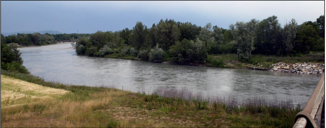
FIGURA 3 – DETTAGLIO AREA DI VALLE PONTE SS26 – ANNO 2005
