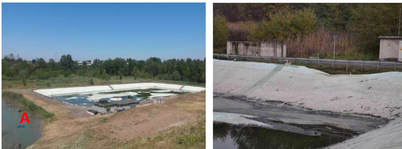
Figura 1: Foto della vasca di laminazione con rigonfiamenti e del ristagno definito in "A" (a sinistra) e foto del punto in cui è franato il fianco.
