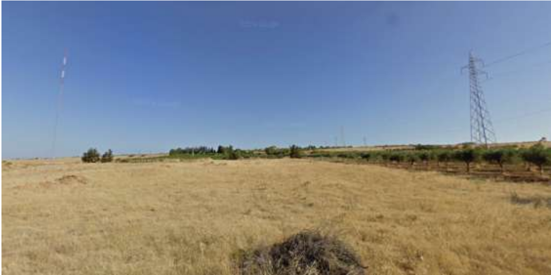
Foto 25-26-27 - Sottostazione di rete
