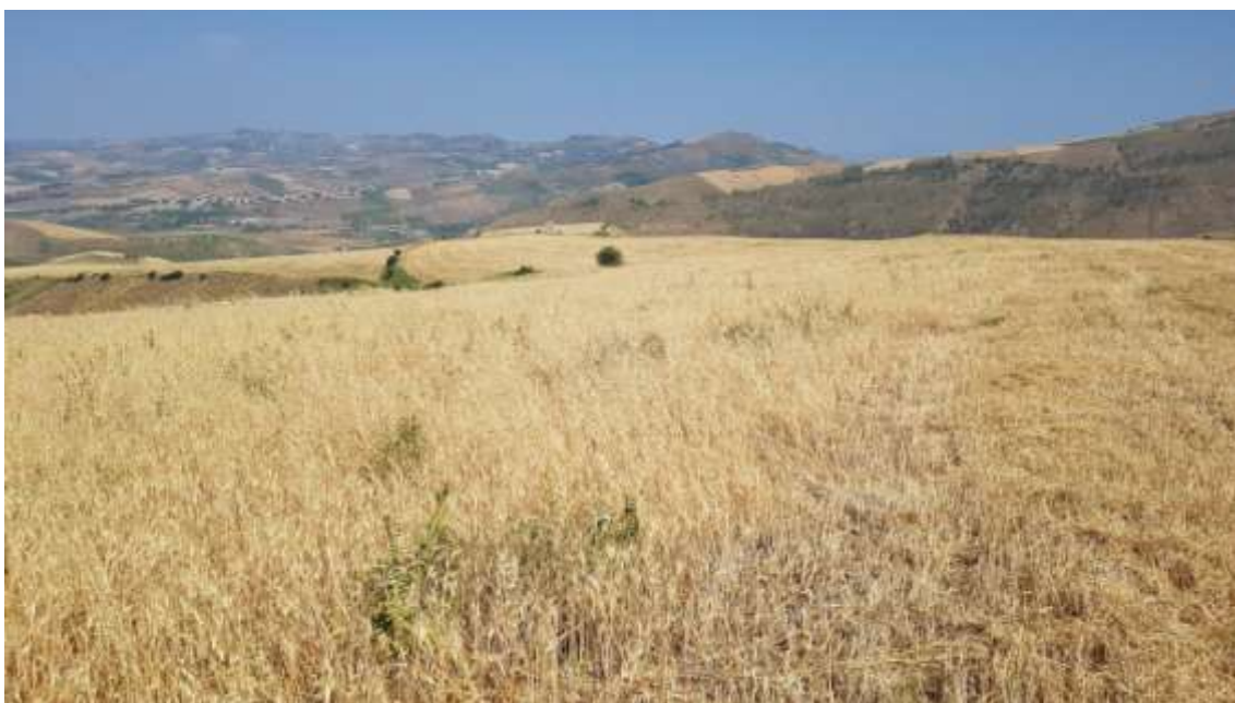
Foto 23 - Vista d'insieme impianto aerogeneratore 8 e 9
