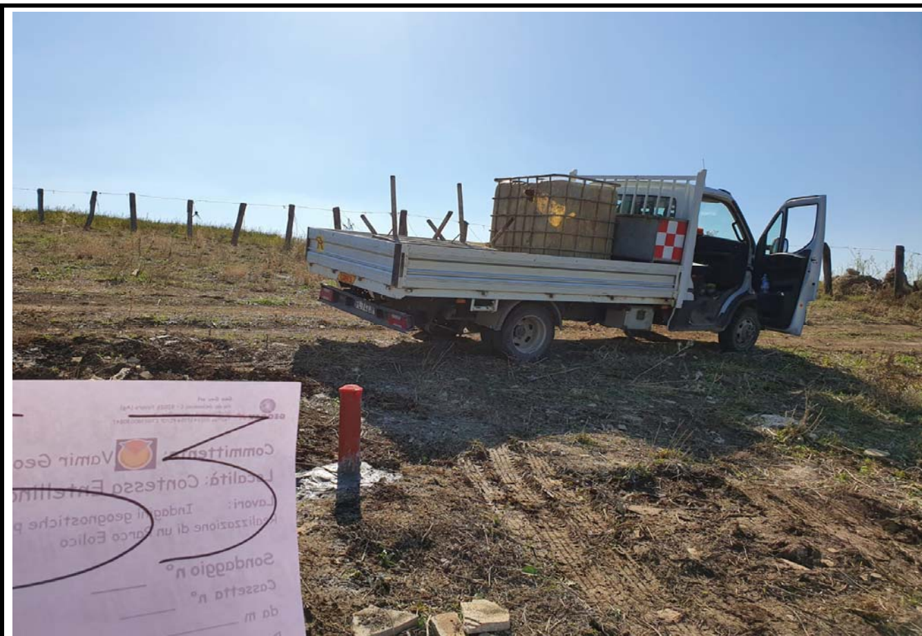
Sondaggio n° S03 Pozzatte di protezione strumentazione geotecnica
