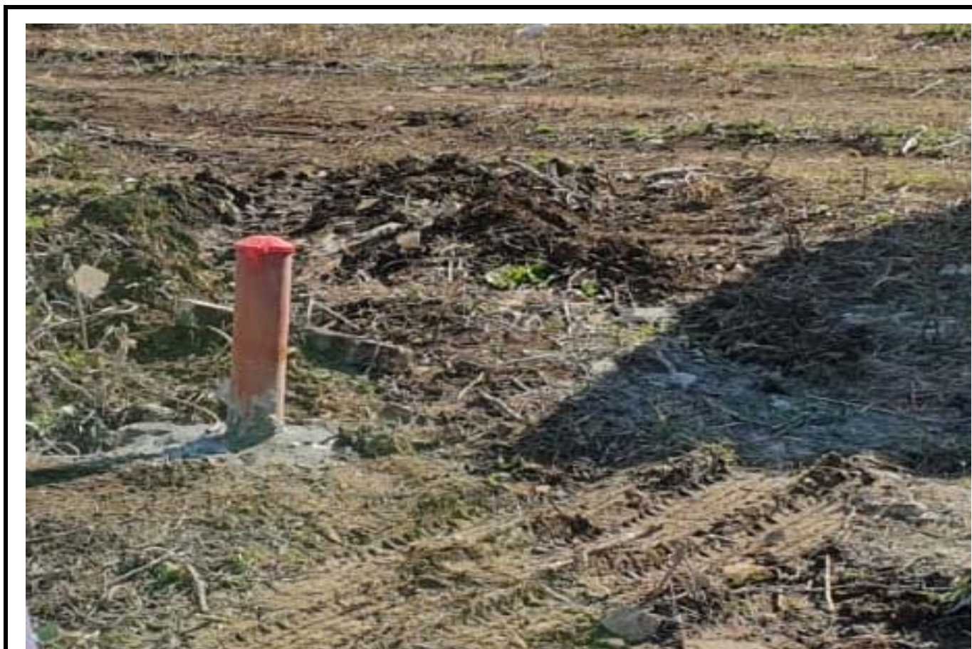
Sondaggio n° S09 Pozzatte di protezione strumentazione geotecnica
