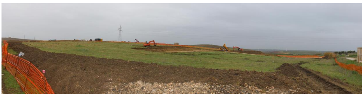
Figura 8 – Panoramica dell’area adiacente alla sottostazione di trasformazione e sulla quale attualmente è in costruzione la stazione di smistamento “Partanna 2”.
