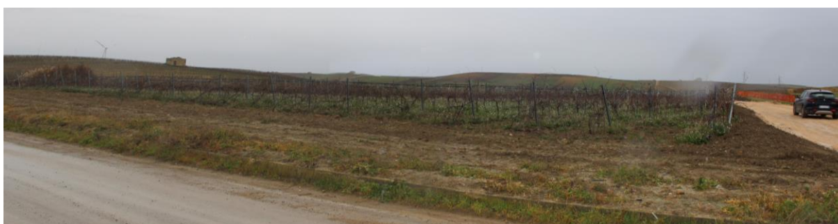
Figura 7 – Panoramica dell’area dove è prevista la realizzazione della sottostazione di trasformazione prevista all’interno dell’area condivisa con altri produttori. Nella panoramica si nota sulla sinistra la “Regio Trazzera Castelvetrano con Biforcazione per Castelvetrano”, in parte adeguata per consentire la realizzazione della stazione “Partanna 2”, sulla quale è prevista la posa di un tratto di cavo AT.
