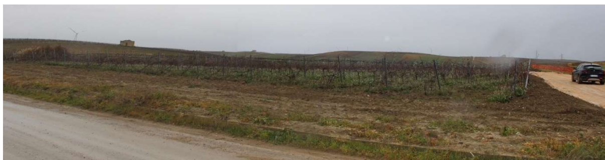
Figura 8 – Panoramica dell'area di realizzazione della sottostazione di trasformazione in area condivisa con altri produttori.
