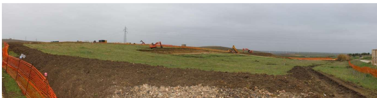
Figura 9 – Panoramica area di costruzione della stazione di smistamento "Partanna 2".
