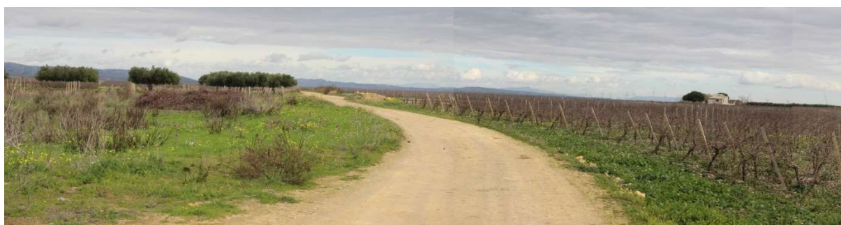
Figura 4 – Panoramica dell'area d'intervento in direzione dell'area d'installazione delle torri A05 – A06
