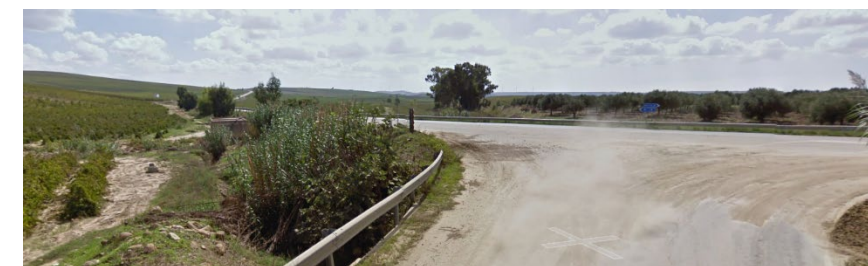
Figura 2 – Attraversamento del Fiume Iudeo in corrispondenza della SS118 – Svincolo sulla SP8
