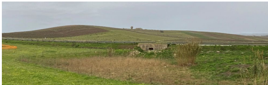
Figura 3 – Canale di scolo in corrispondenza della SS118
