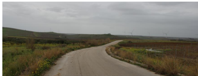
Figura 8 – incrocio tra la strada comunale "Iudeo Carcitrillo" e la "Contrada Carcitrilla" (strada asfaltata).
