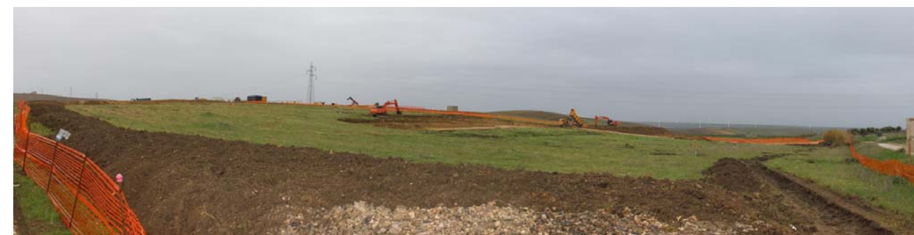
Figura 9 – Panoramica dell'area adiacente alla sottostazione di trasformazione e sulla quale attualmente è in costruzione la stazione di smistamento “Partanna 2”.
