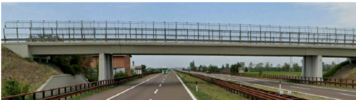
Figura 2: Veduta del sovrappasso (Fonte: Allegati alla Lista di controllo)
