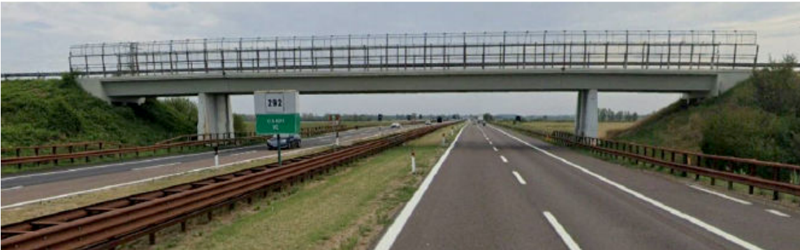
Figura 2: Veduta del sovrappasso (Fonte: Allegati alla Lista di controllo)
