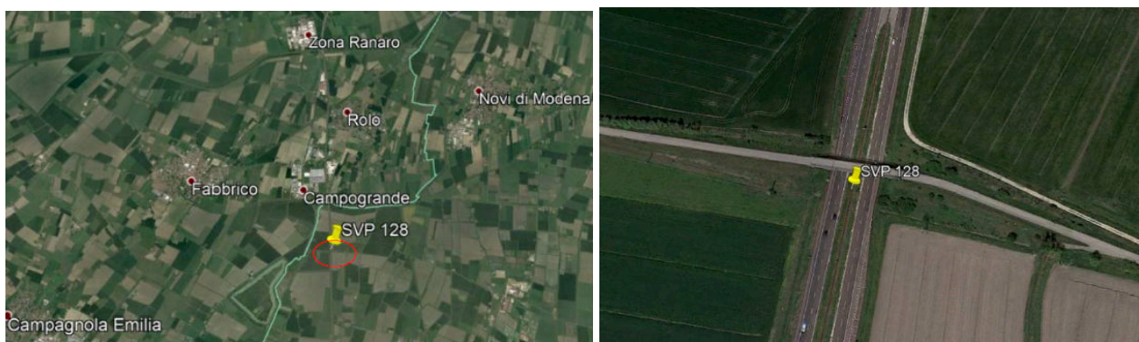
Figura 1: Inquadramento su ortofoto sovrappasso n. 128 (Fonte: Allegati alla Lista di controllo)
