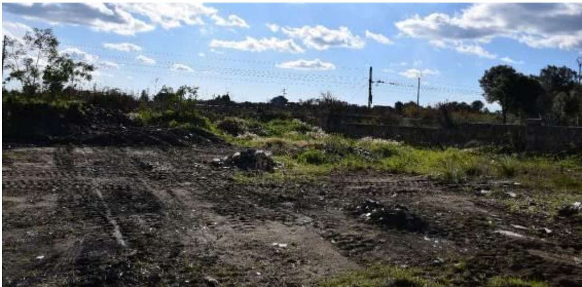
Figura 26: punto di uscita del tratto di cavidotto posato in TOC per superare la ferrovia
