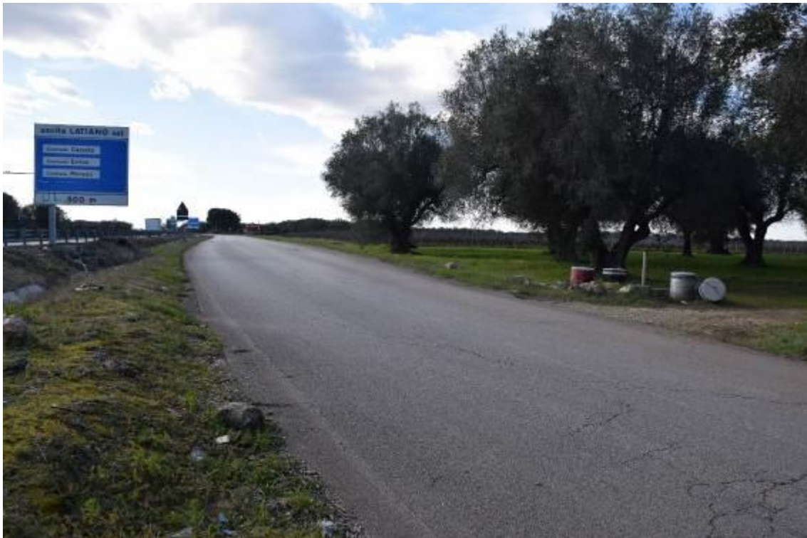
Figura 28: complanare della E90 (SS7) in prossimità del punto di uscita della TOC. Il cavidotto sarà posato in banchina stradale
