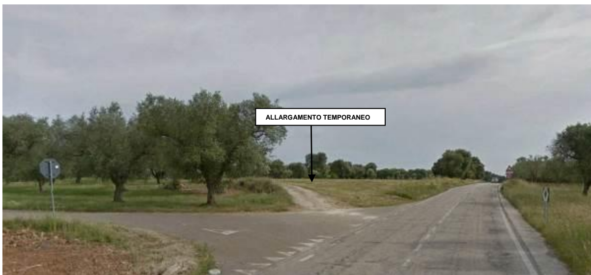
Figura 17 - Incrocio tra SP69 e strada locale asfaltata di accesso all'aerogeneratore A05 che necessita di allargamento temporaneo.
