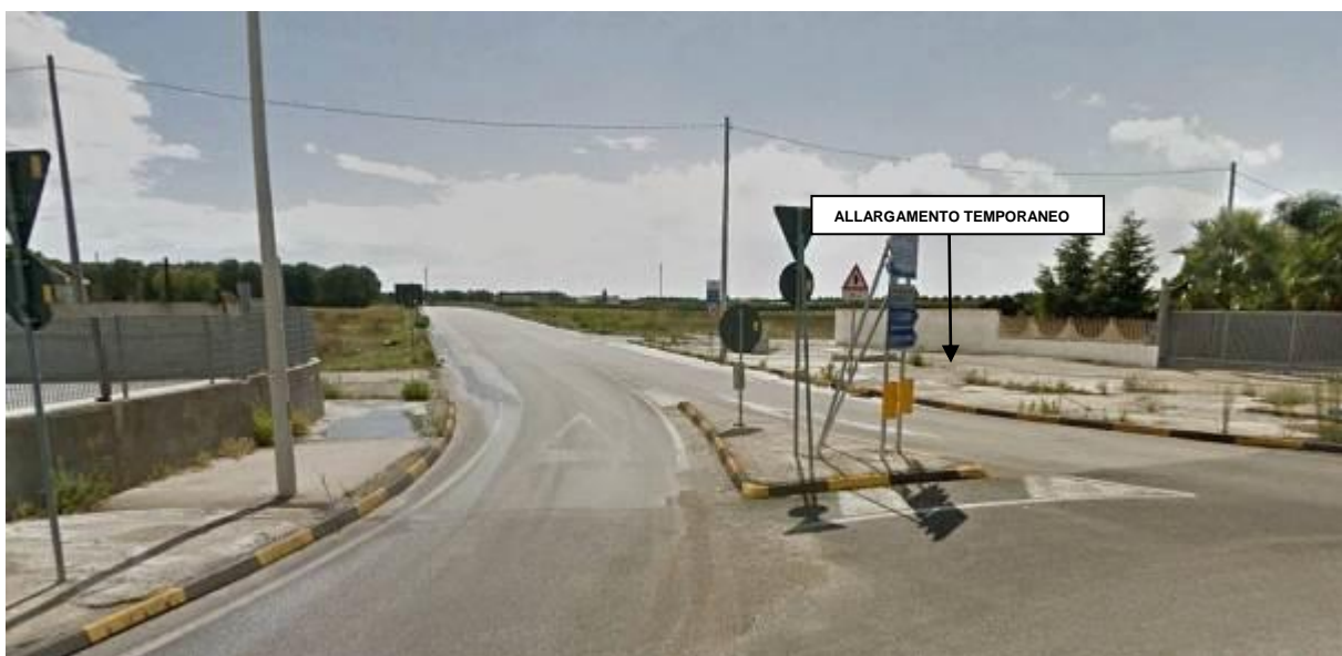
Figura 14 - Incrocio tra SPN.45 e Circonvallazione Sud di Mesagne che necessita di allargamento temporaneo. Sarà necessario fare pochi interventi di sistemazione e di spostamento temporaneo della cartellonistica stradale.
