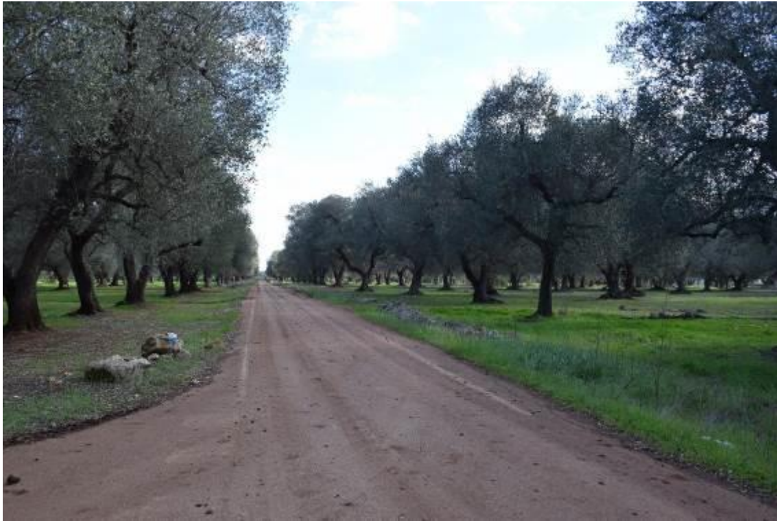
Figura 31: tratto di strada interessato dalla posa del cavidotto (in prossimità della strada di accesso alla stazione elettrica)
