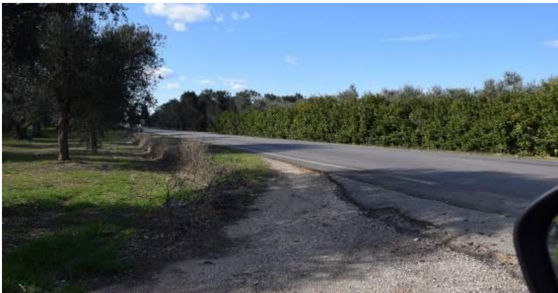
Figura 24: particolare dell'intersezione tra la strada imbrecciata e la SP 45. Sulla SP il cavidotto sarà posato in banchina
