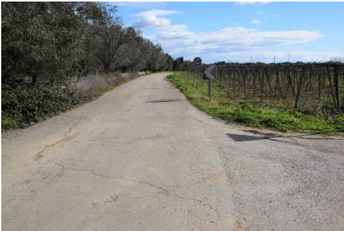
Figura 22: Cavidotto esterno nel tratto iniziale sulla SP 73
