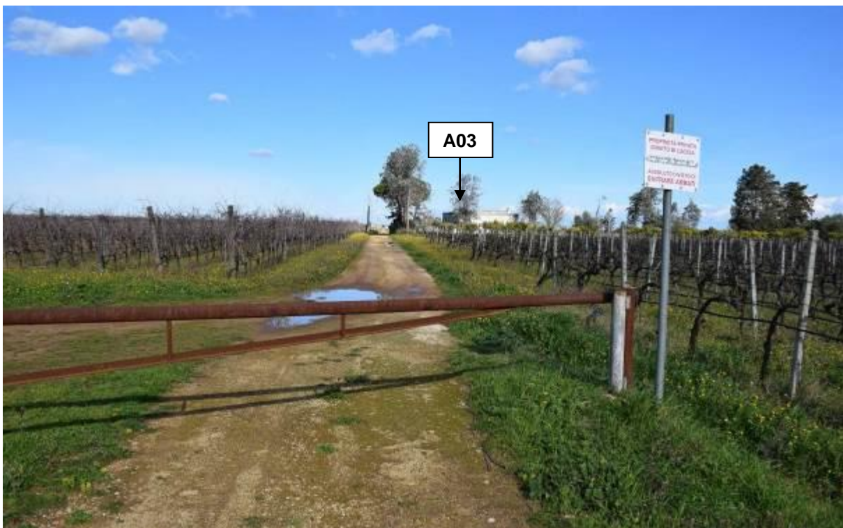
Figura 6 – Vista della strada imbrecciata di accesso all’aerogeneratore A03. Tale strada, interessata anche dalla posa del cavidotto MT, sarà adeguata per necessità dovute al transito di mezzi di trasporto delle strutture costituenti degli aerogeneratori.
