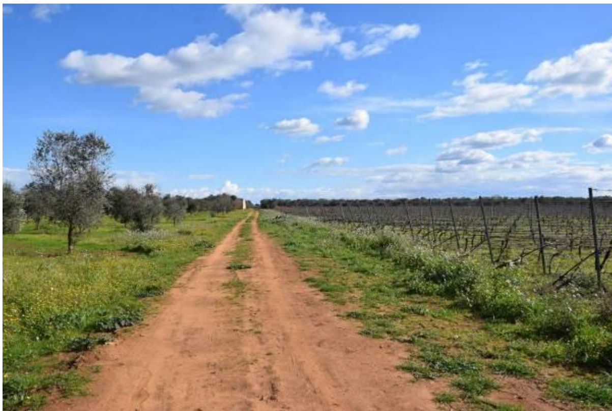
Figura 12 – Strada locale, senza denominazione, di accesso all’aerogeneratore A04. Come si nota dalla fotografia, è evidente la necessità di adeguamento della viabilità esistente.
