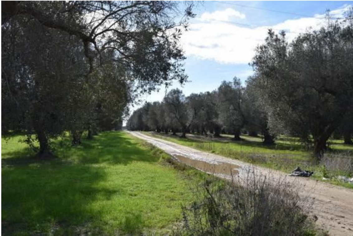
Figura 19: tipica strada di collegamento tra gli aerogeneratori dell'impianto. Il cavidotto interno sarà posato al margine delle stesse. Nella foto, in particolare, è ripresa la strada di collegamento tra l'aerogeneratore A02 e A01.
