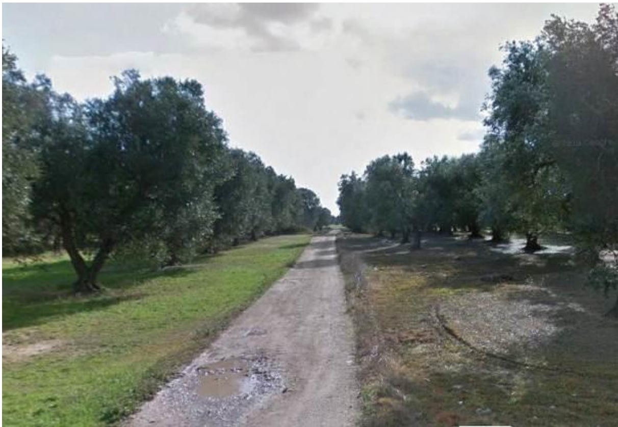
Figura 11 – Strada locale, senza denominazione, di accesso all'aerogeneratore A02. Come si scorge dalla fotografia, è evidente la necessità di adeguamento della viabilità esistente e allargare la carreggiata.
