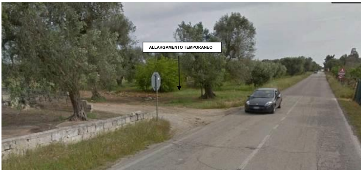
Figura 16 - Incrocio tra SP69 e strada locale sterrata di accesso agli aerogeneratori A03 e A04 che necessita di allargamento temporaneo.
