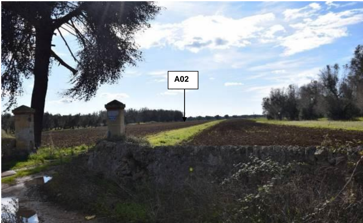
Figura 5 – Vista dalla strada esistente in terra battuta dell’area d’impianto in prossimità dell’aerogeneratore A02. Tale strada, interessata anche dalla posa del cavidotto MT, sarà adeguata per necessità dovute al transito di mezzi di trasporto delle strutture costituenti degli aerogeneratori.
