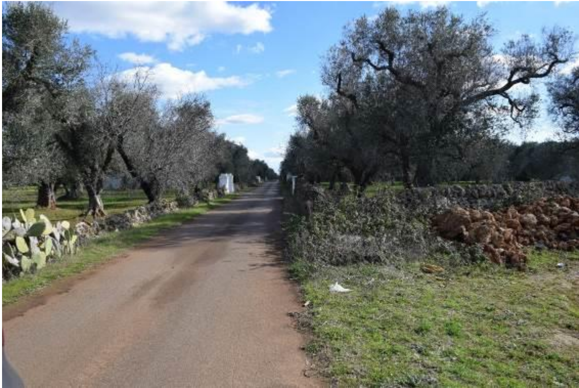
Figura 21: strada comunale asfaltata su cui è posato il tratto di cavidotto interno tra la A06 e A05.
