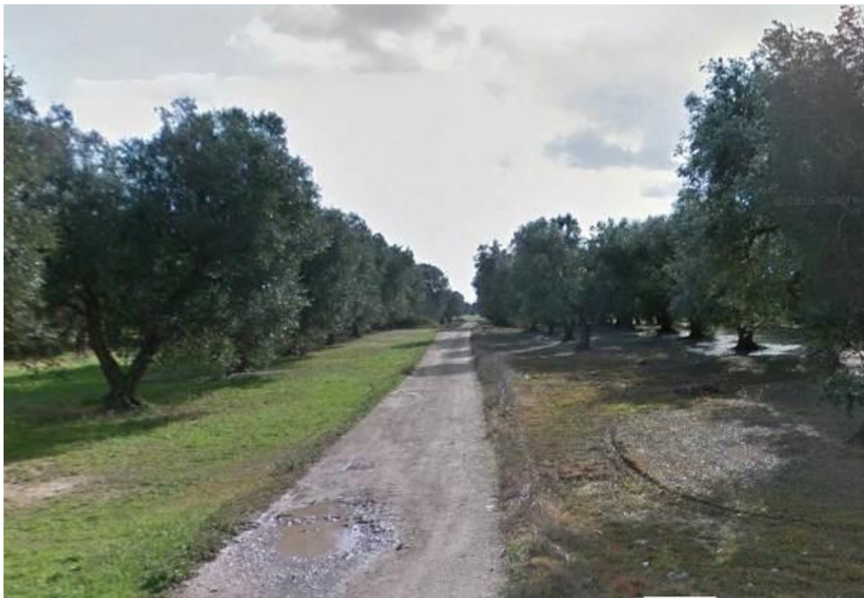
Figura 6 – Strada locale, senza denominazione, da adeguare e lungo la quale è prevista la posa del cavidotto di collegamento tra l'aerogeneratore A02 e l'aerogeneratore A01.
