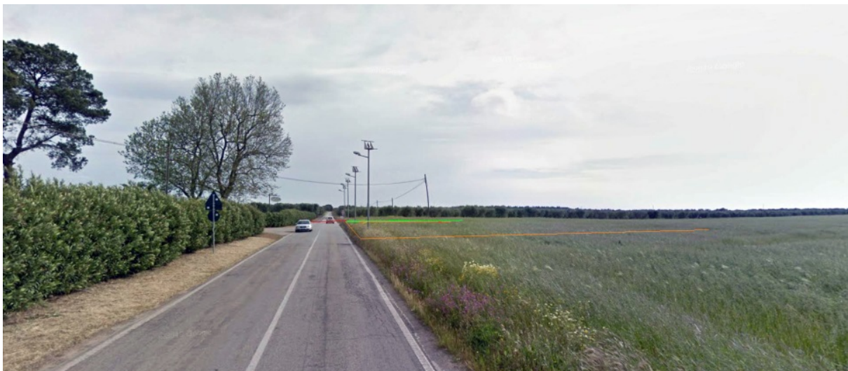
Figura 4 - punto di attraversamento della SP 69 da parte del cavidotto interno e a destra, un'area da adibire temporaneamente a servizio del cantiere, che sarà smantellata e ripristinata a fine lavori.
