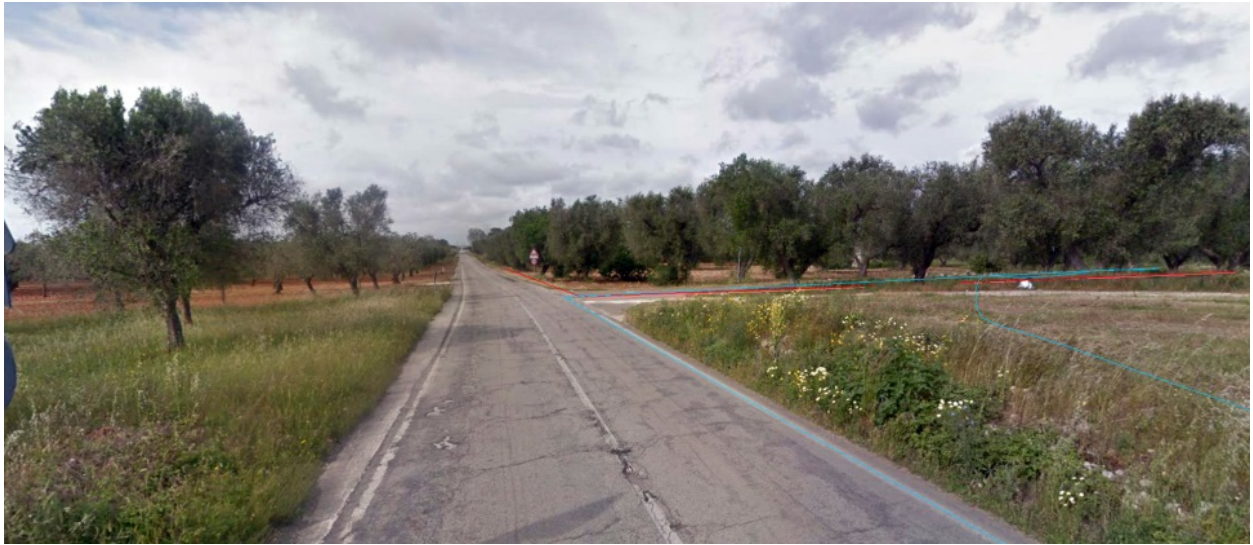
Figura 3 tracciato del cavidotto interno interrato e allargamento temporaneo lungo la strada di interesse paesaggistico SP 69.
