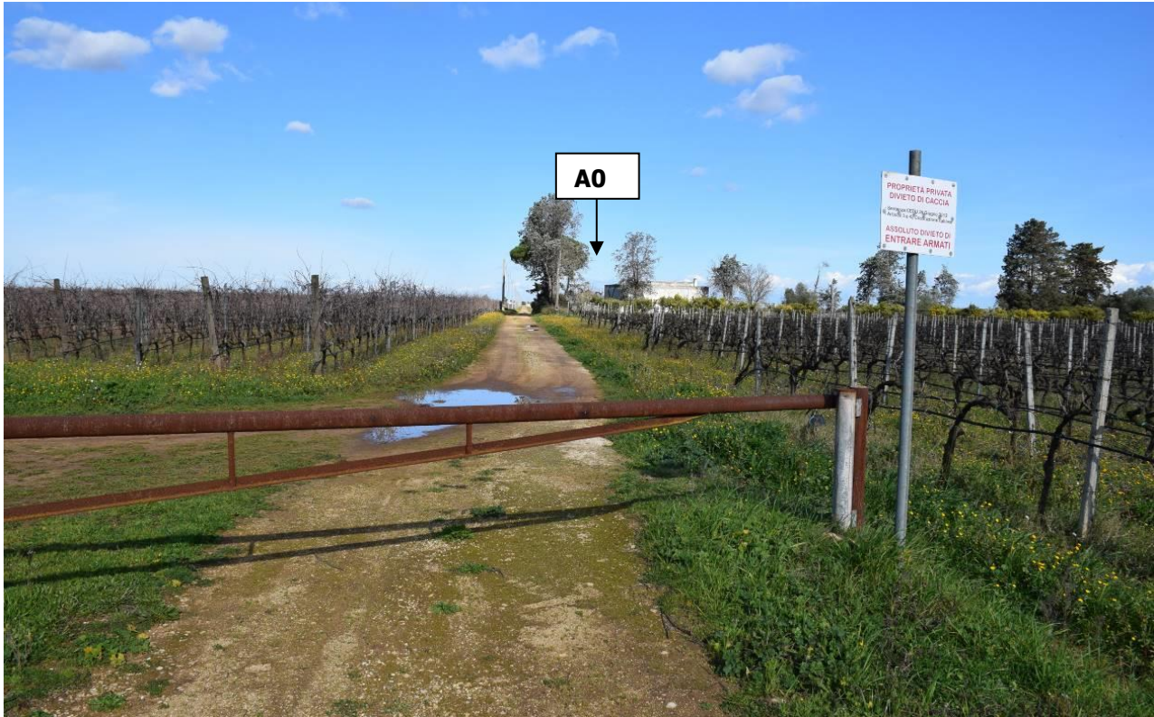
Vista della strada in terra battuta di accesso all'aerogeneratore A03. Tale strada, interessata anche dalla posa del cavidotto MT, per necessità dovute al transito di mezzi di trasporto delle strutture costituenti degli aerogeneratori, sarà adeguata.
