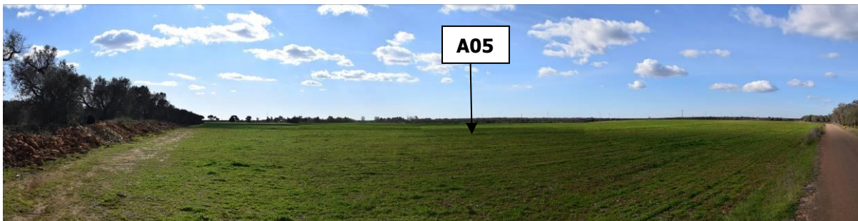
Vista dell'area d'impianto in prossimità dell'aerogeneratore A05 accessibile da strada locale asfaltata senza denominazione. Tale strada, interessata anche dalla posa del cavidotto MT, per necessità dovute al transito di mezzi di trasporto delle strutture costituenti degli aerogeneratori, sarà adeguata puntualmente.
