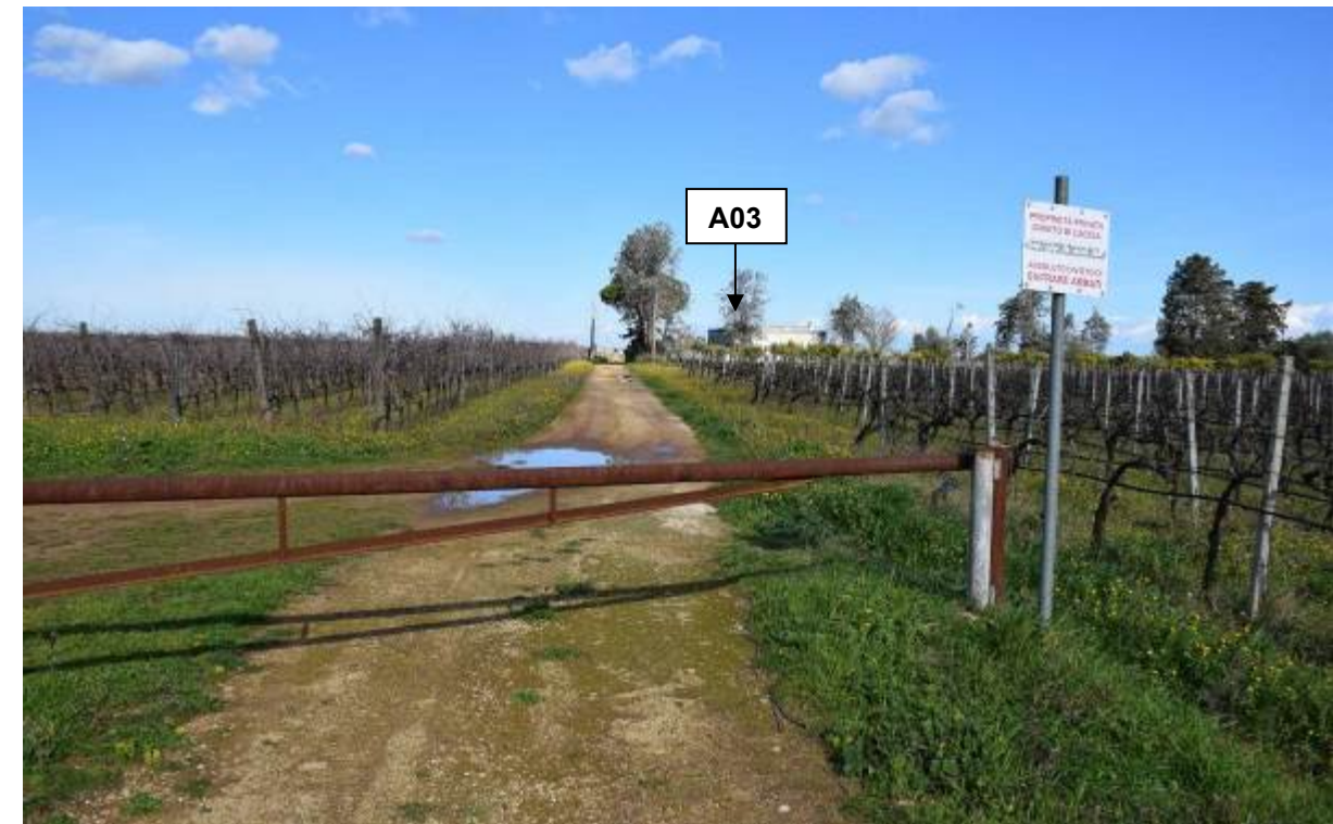
Figura 3 – Vista della strada imbrecciata di accesso all'aerogeneratore A03. Tale strada, interessata anche dalla posa del cavidotto MT, sarà adeguata per necessità dovute al transito di mezzi di trasporto delle strutture costituenti degli aerogeneratori.
