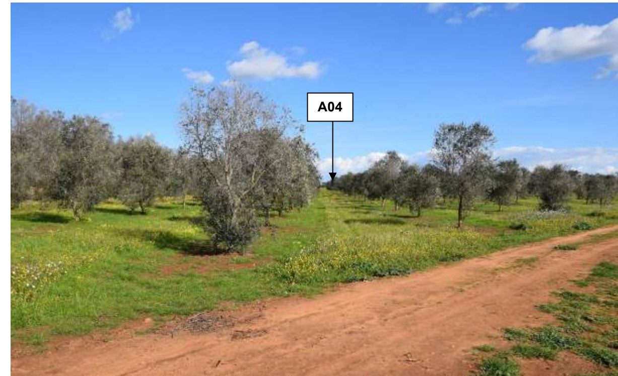
Figura 4 – Vista dell'area d'impianto in prossimità dell'aerogeneratore A04 accessibile da strada locale in terra battuta. Tale strada, interessata anche dalla posa del cavidotto MT, per necessità dovute al transito di mezzi di trasporto delle strutture costituenti degli aerogeneratori, sarà adeguata. Si evidenzia la presenza dell'uliveto di giovane impianto.
