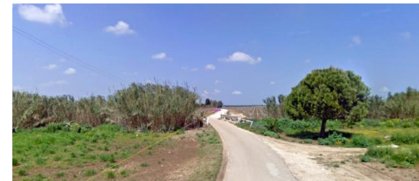
Figura 4.1 Attraversamento del cavidotto esterno su “Canale Reale”;
