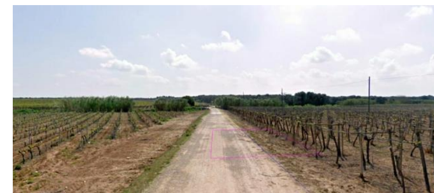
Figura 4.2 Attraversamento del cavidotto esterno su “Canale Reale” (controcampo)
