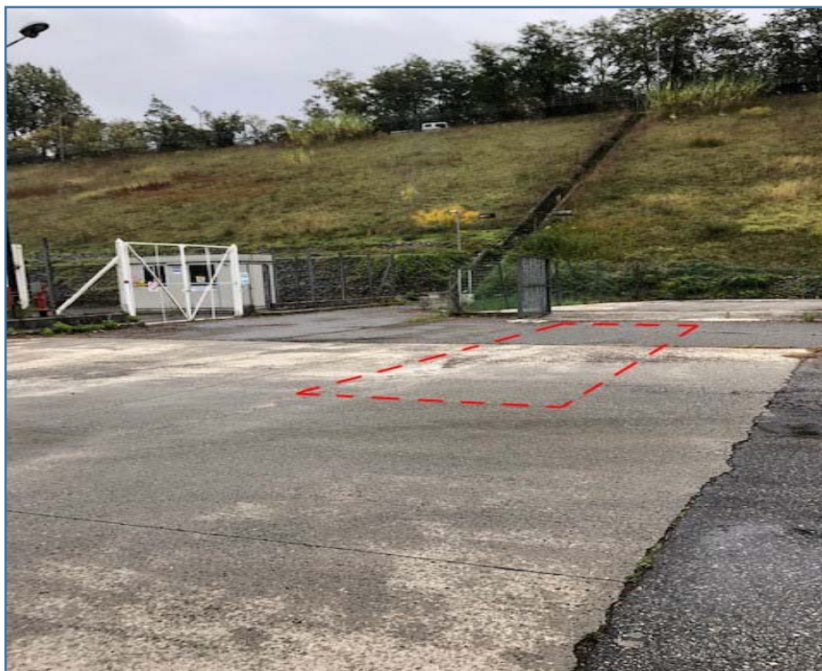
Foto 1: Zona di collocazione caldaia ausiliaria
