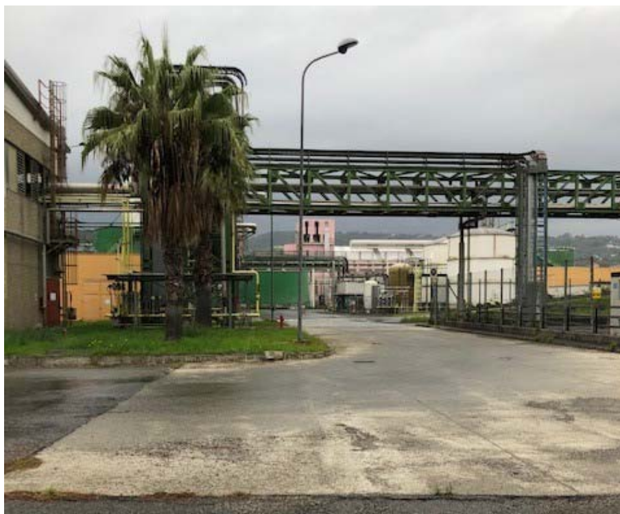
Foto 2: Zona di collocazione collegamento alla rete esistente
