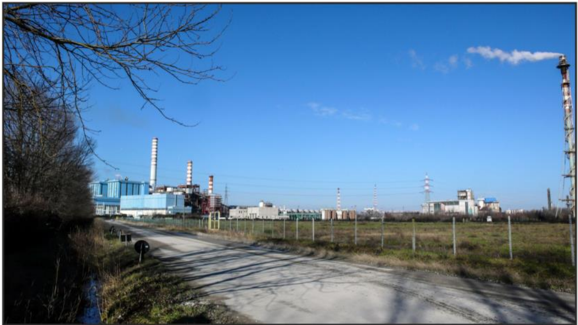
FUSINA - CENTRALE ENEL - ANDREA PALLADIO - - VISTA 2 - STATO ATTUALE -
