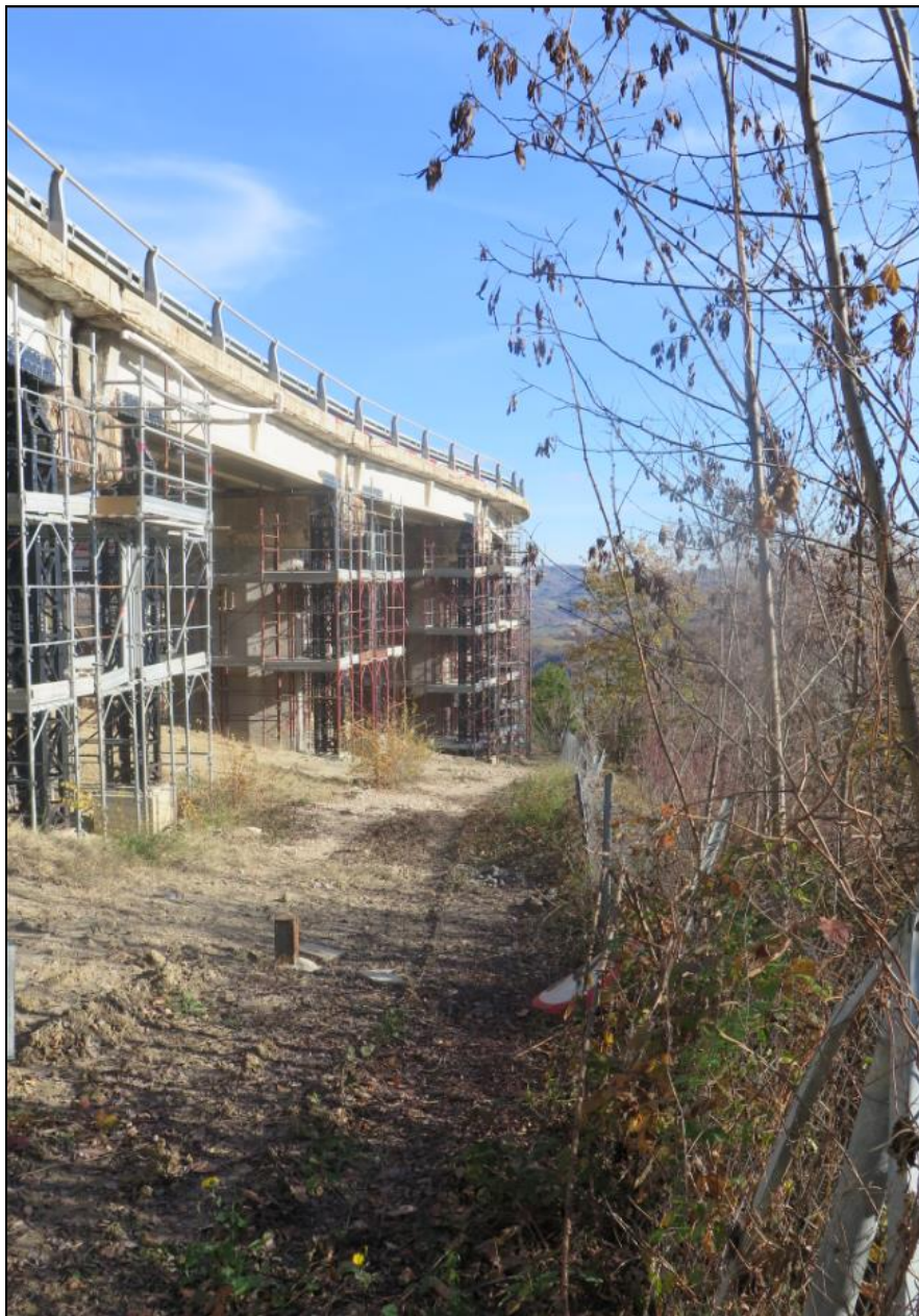
Foto: 1: Stato di fatto- vista 1
