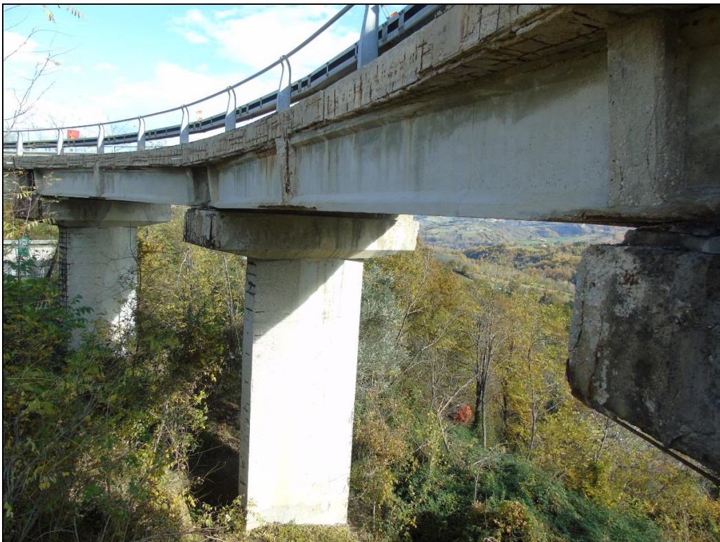
Foto 3 :stato di fatto - vista 3
