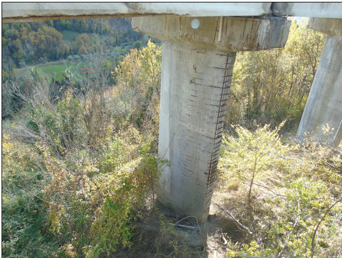
Foto 4: stato di fatto - vista 4
