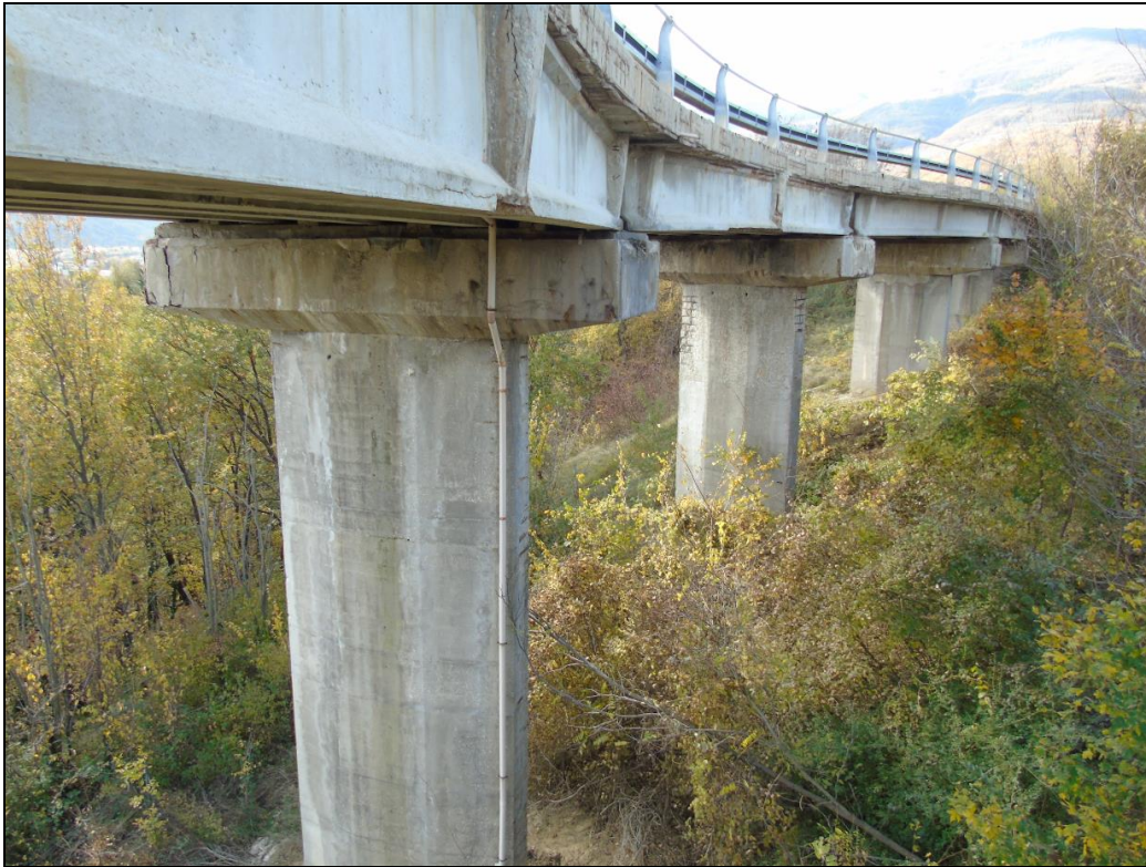
Foto 2: stato di fatto - vista 2
