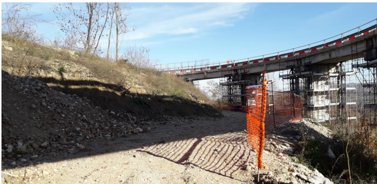
Foto 5 : stato di fatto - vista 5
