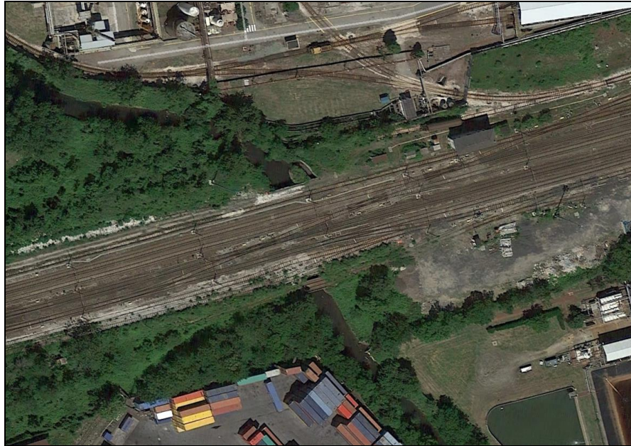
Figura 2.3 – Foto attraversamento ferroviario attuale (Google Earth)
