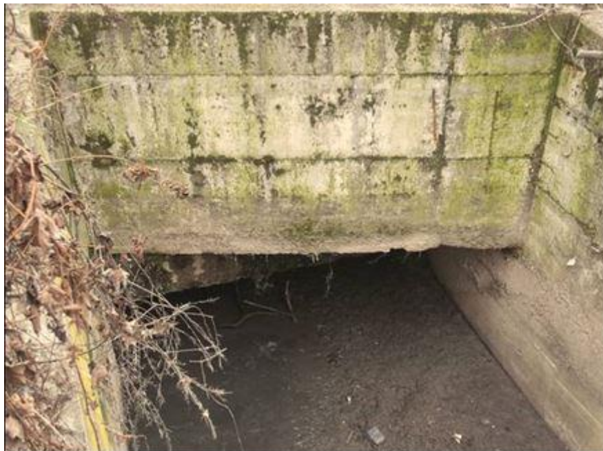
Figura 2.5 – Foto attraversamento canale secondario esistente sul Fiume Olona
