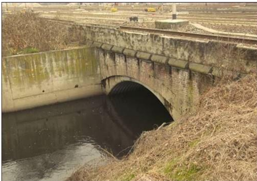
Figura 2.4 – Foto attraversamento ferroviario esistente sul Fiume Olona
