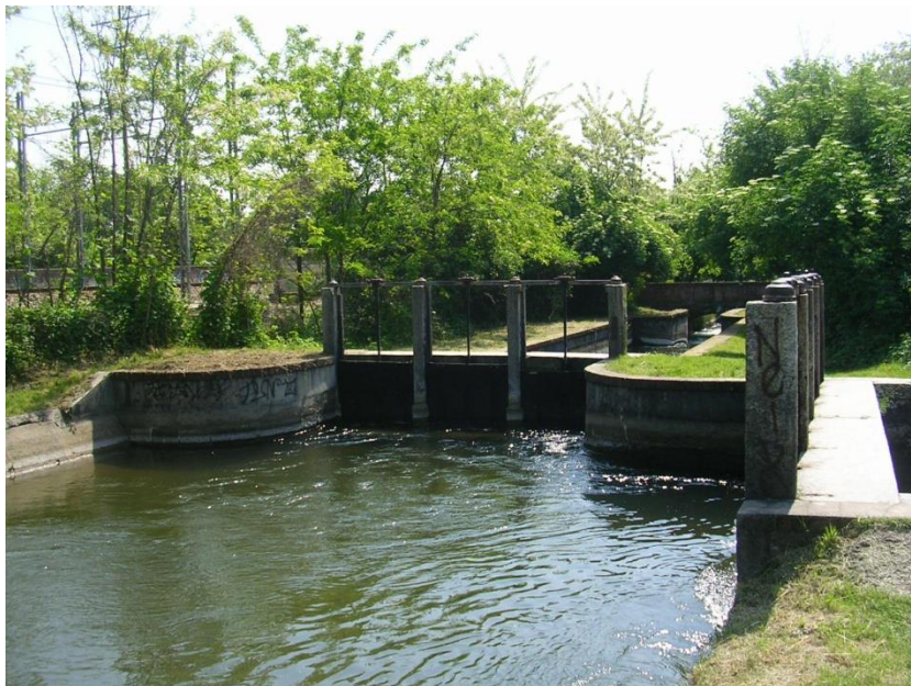
Figura 4.4: Vista del manufatto partitore.
