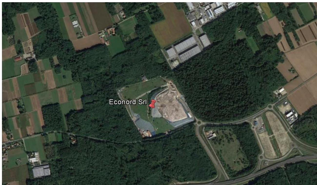
Figura 24: Foto aerea della discarica di rifiuti non pericolosi di Gorla Maggiore/Mozzate (VA/CO)
