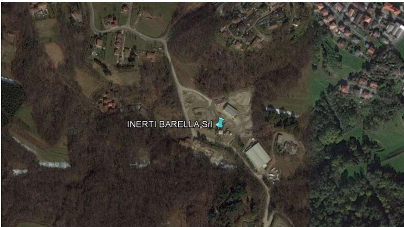
Figura 12: Foto aerea dell'impianto di recupero di Parè (CO)
