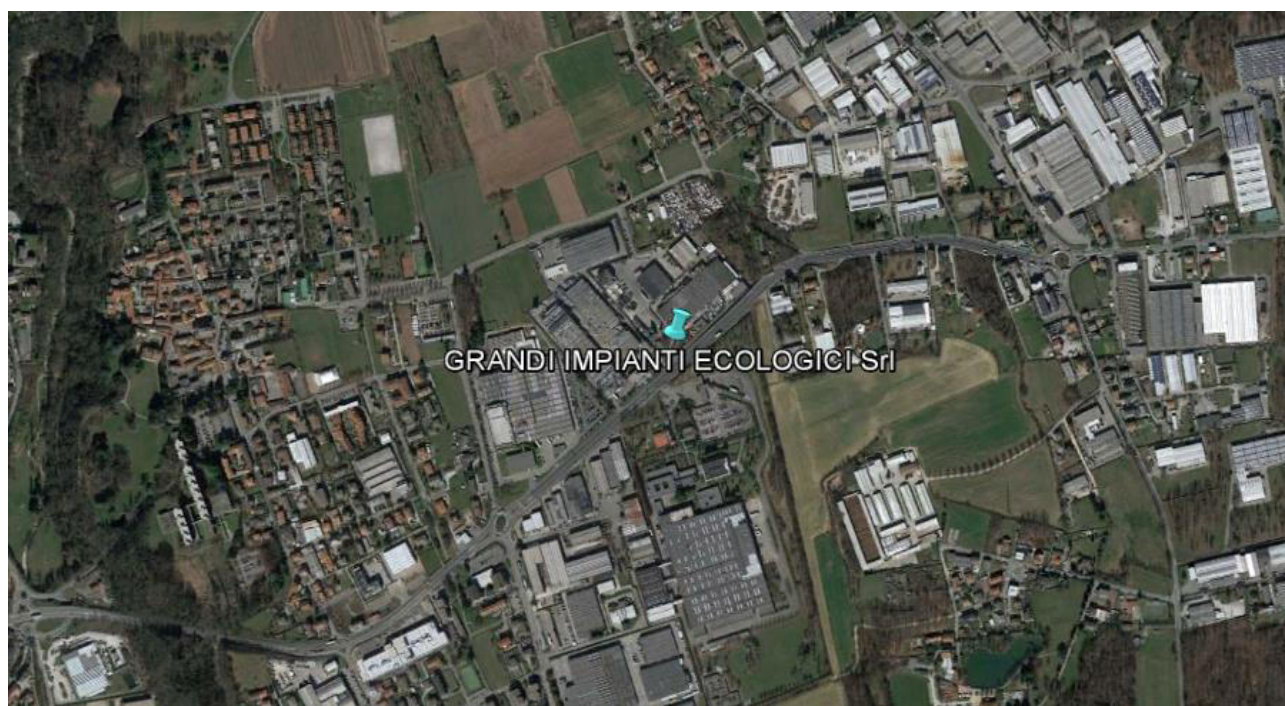
Figura 16: Foto aerea dell'impianto di recupero di Novadrate (CO)
