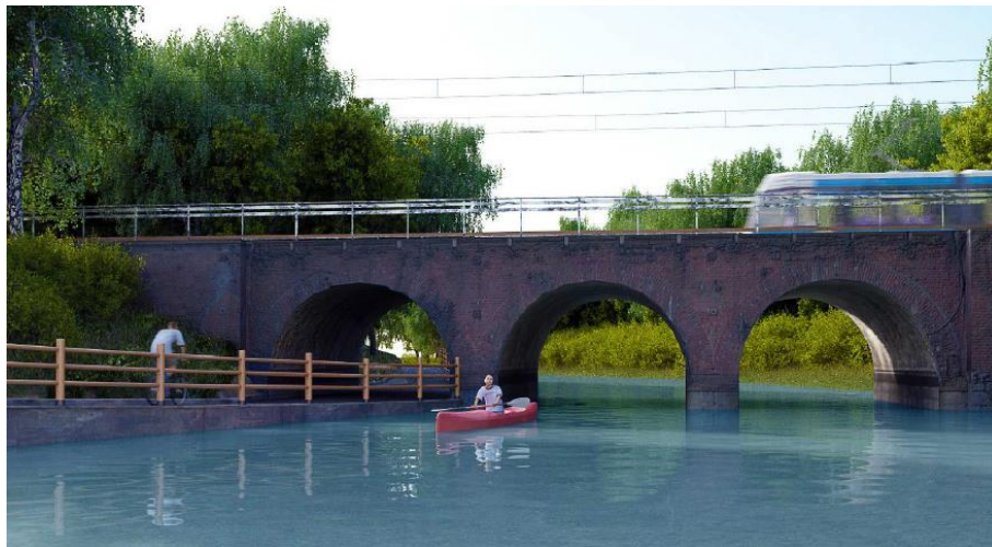
Figura 8-4 Scavalco del Villoresi - Impalcato esistente
