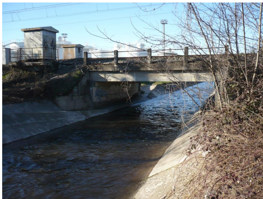
Figura 8-1 Foto dello stato esistente
