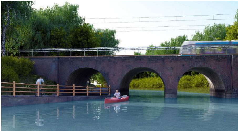
Figura 4.2 Ponte ferroviario su Canale Villoresi vista da valle (Pista ciclabile in destra idraulica)
