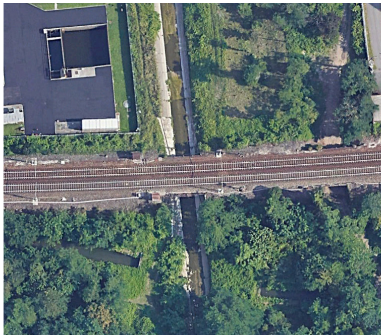
FIGURA 3.7 - FOTO ATTRAVERSAMENTO FERROVIARIO ATTUALE (GOOGLE EARTH)
