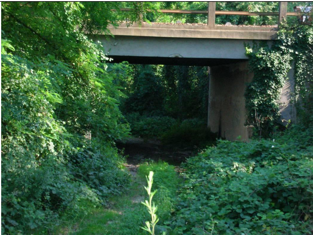
Vista del sottovia di accesso all'area (sottoattraversamento della linea ferroviaria Rho-Arona).
