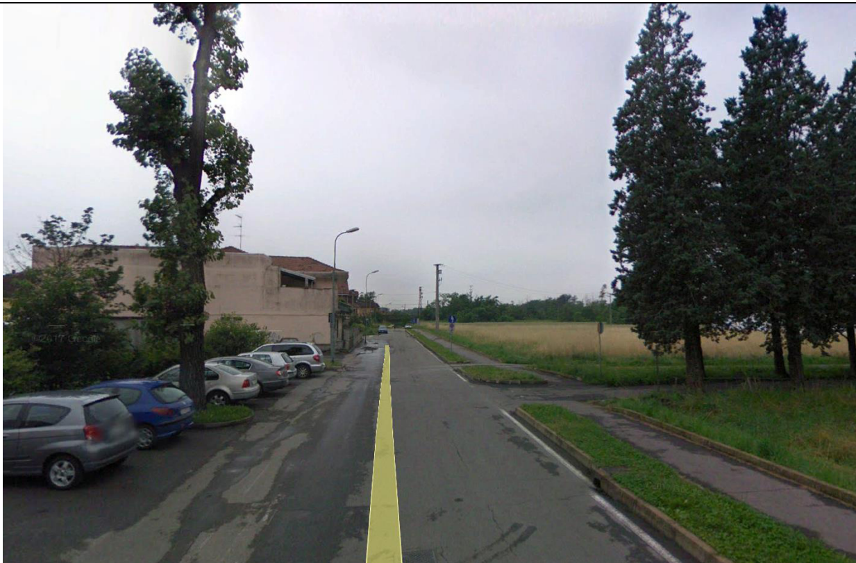
Vista della posizione dove inizierà la pista di cantiere (sulla DX) da Via Arluno.
