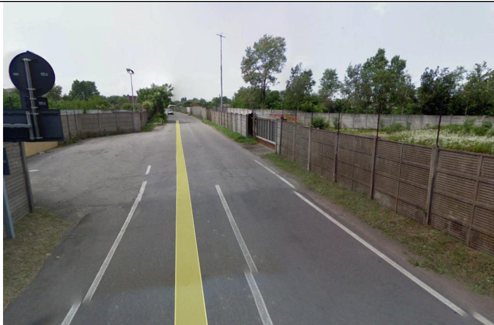
Vista del cancello di ingresso (sulla DX) all'area tecnica da via Vanzago.
