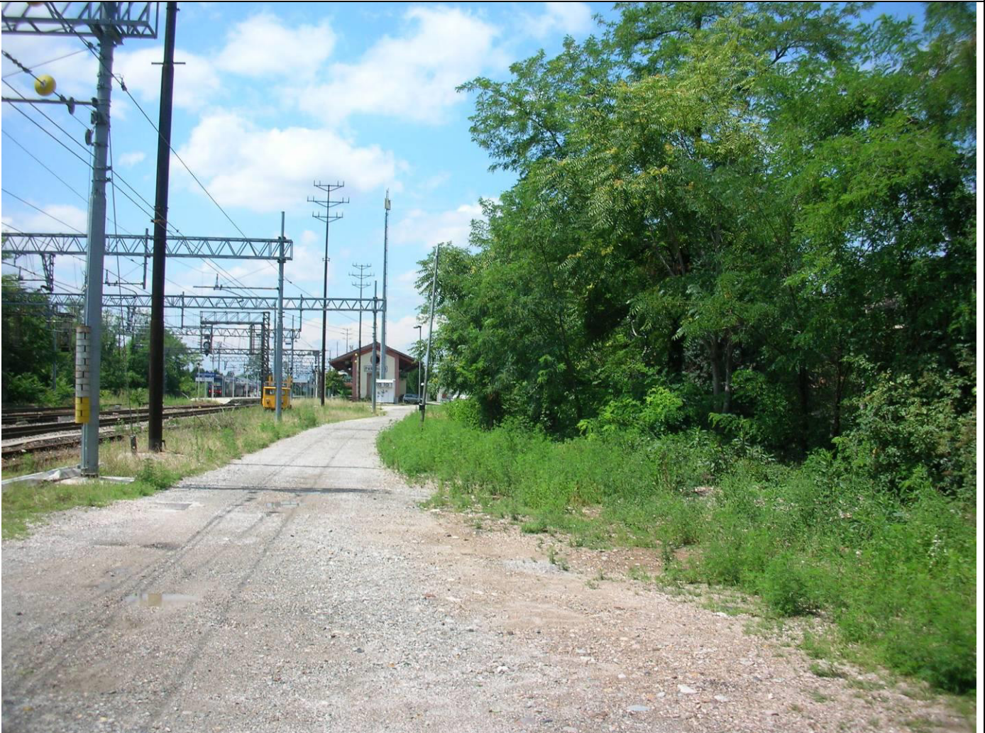
Vista dell'area di cantiere.
