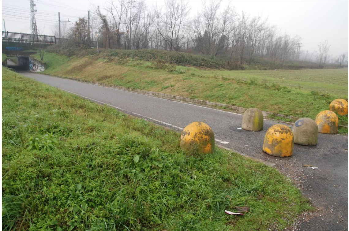
Vista della porzione dell'area tecnica sul lato nord della linea ferroviaria.
