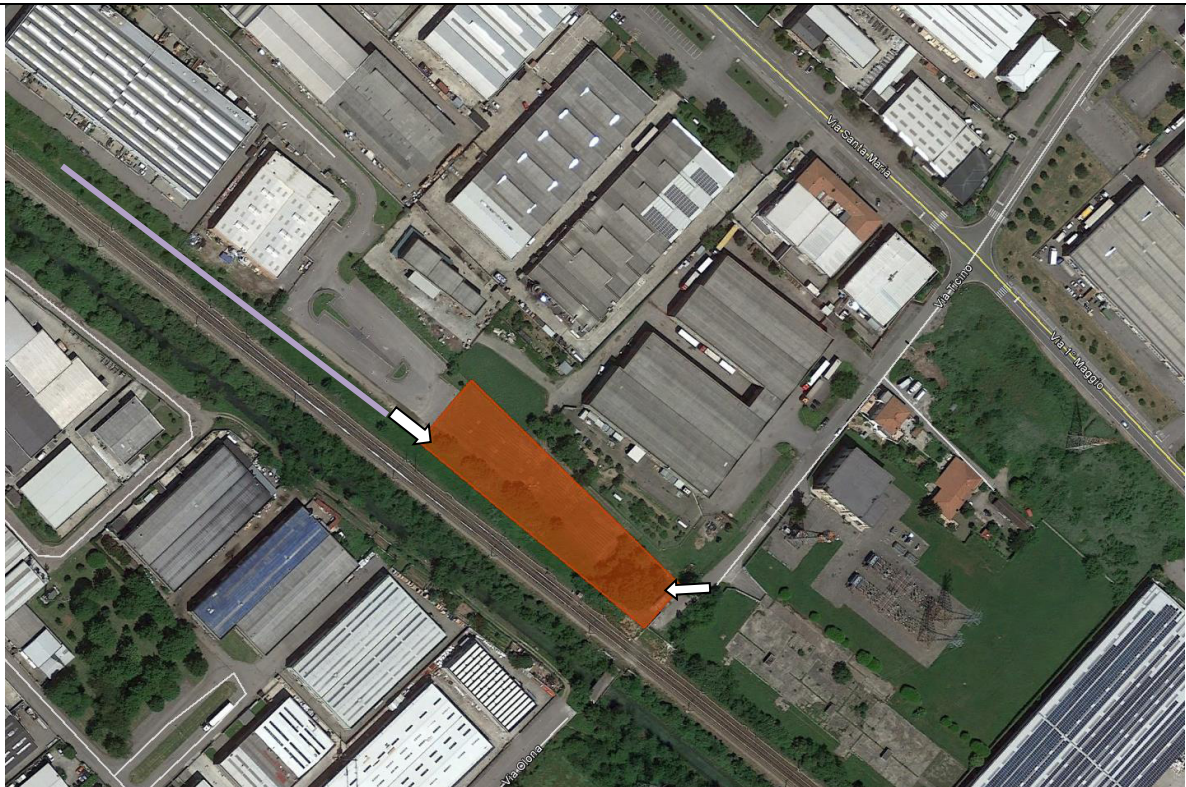
Vista aerea dell'area in cui si inserisce il cantiere, sulla destra, la via Olona (ortofoto da Google Earth, aggiornamento 2017).
