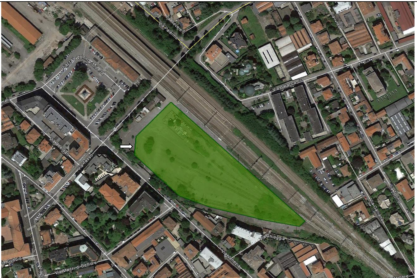
Vista aerea dell'area destinata al cantiere di armamento (ortofoto da Google Earth, aggiornamento 2017).
