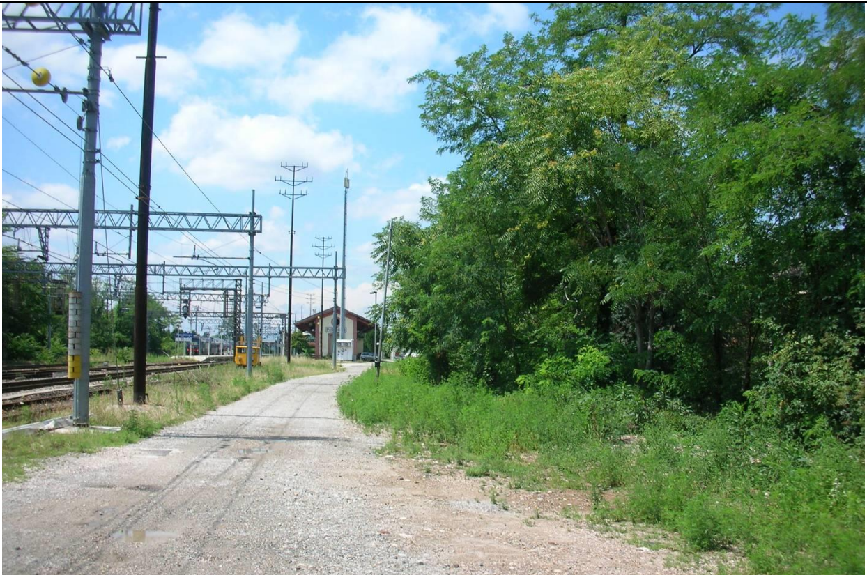
Vista dell'area di cantiere.
