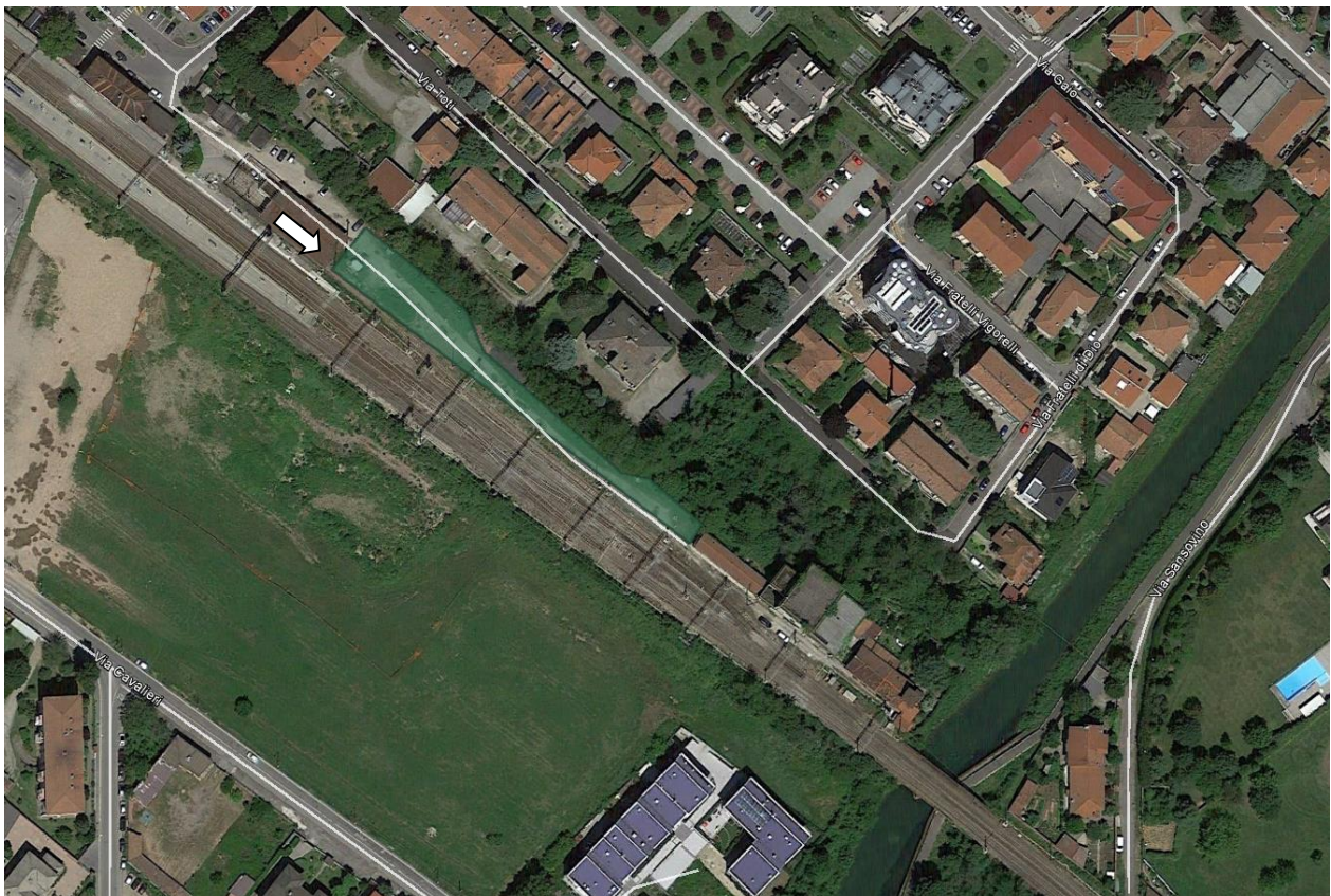
Vista aerea dell'area in cui si inserisce il cantiere; all'estremità destra è visibile il canale Villorosi (ortofoto da Google Earth, aggiornamento 2017).
