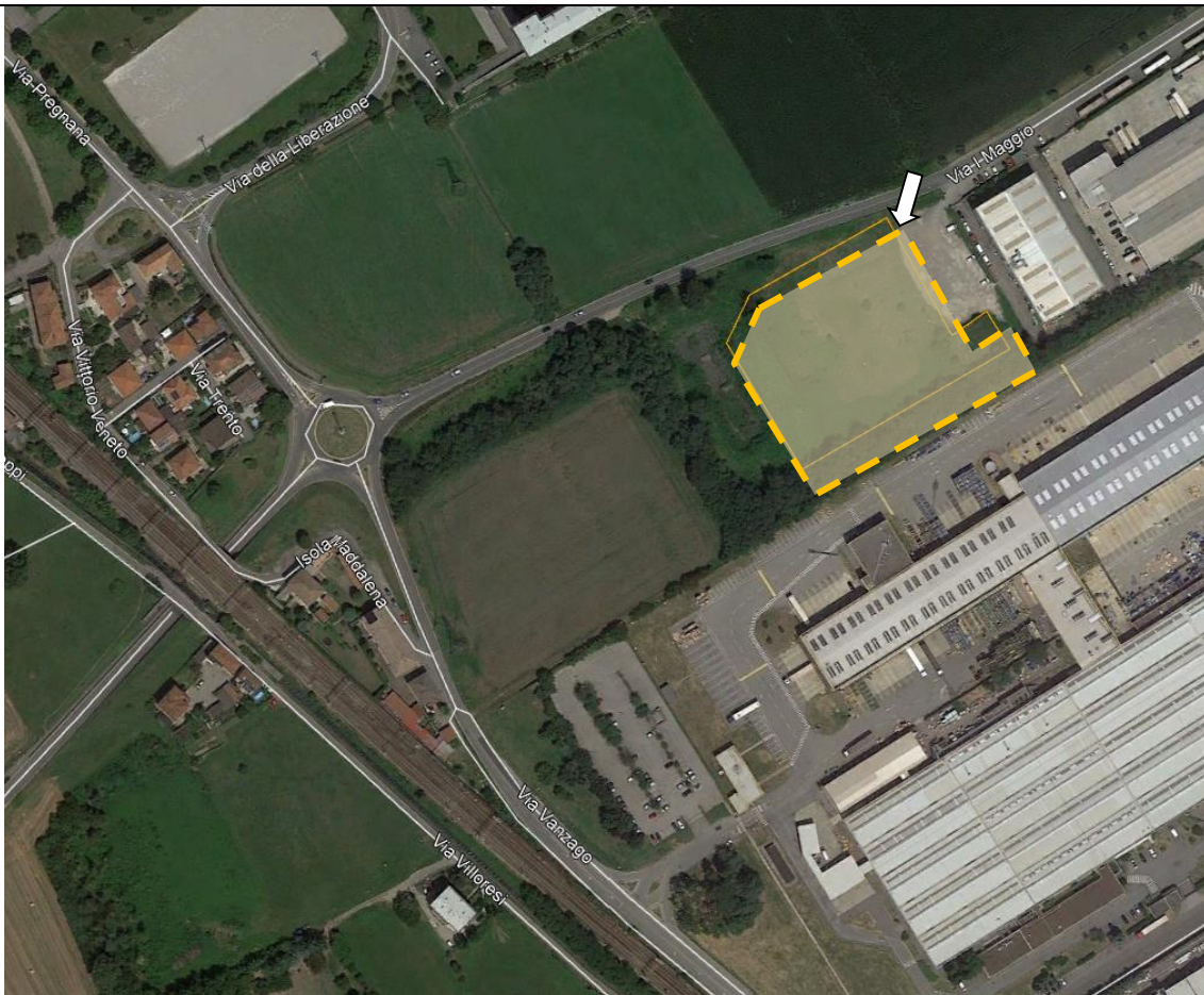
Vista aerea dell'area in cui si inserisce il cantiere, a nord della linea ferroviaria (ortofoto da Google Earth, aggiornamento 2021).
