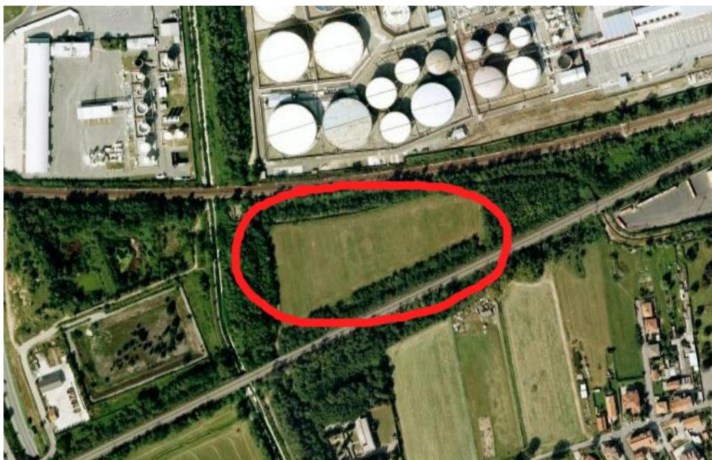
Localizzazione area dell'area tecnica Scavalco (dx)
