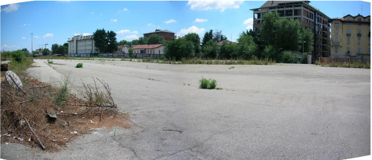
Vista del piazzale di scalo destinato al cantiere.
