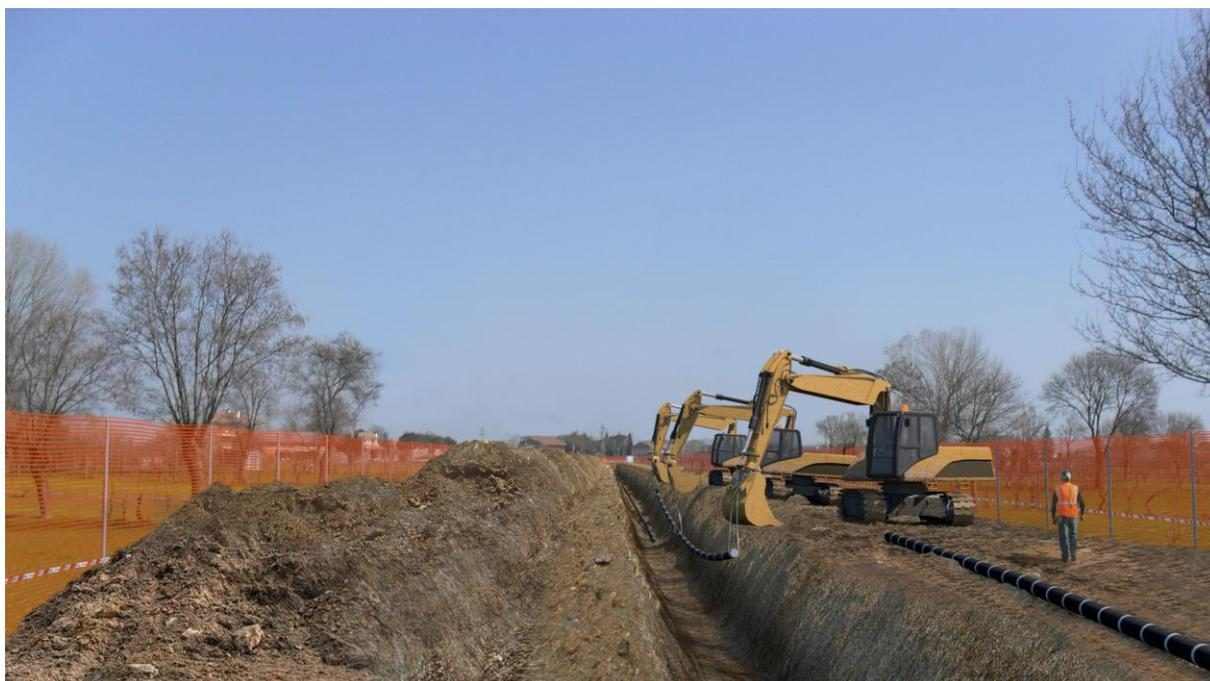
**Fig. 3.2/E: Esempio di Posa della condotta**
