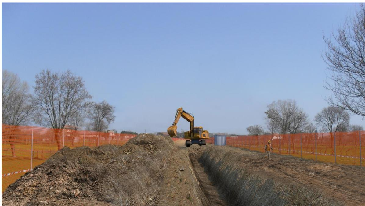
**Fig. 3.2/D: Esempio di scavo della trincea**
