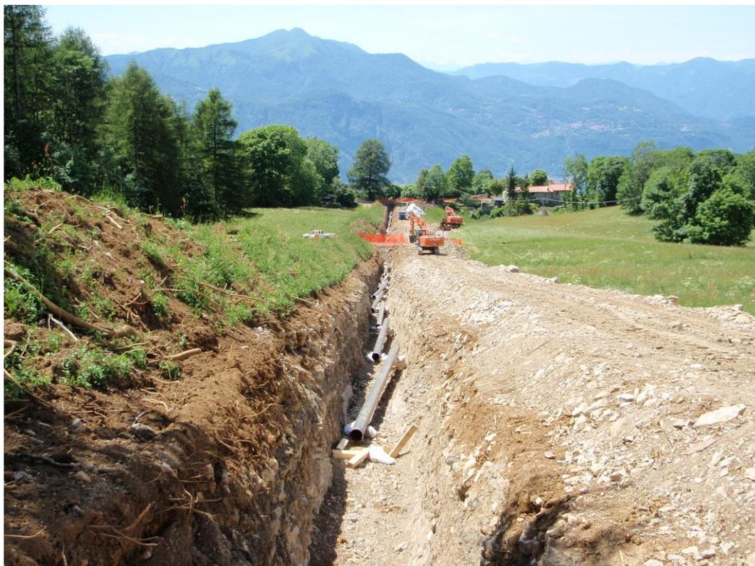
**Fig. 3.2/C: Esempio di sfilamento delle tubazioni**
