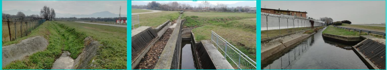
Fig. 2.17: Canali di scolo delle acque presenti entro sedime (foto: sopralluogo 2018)
