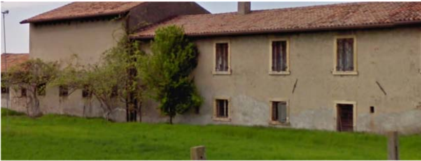
vista lato sud del corpo sud
