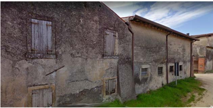
vista lato est del corpo sud
