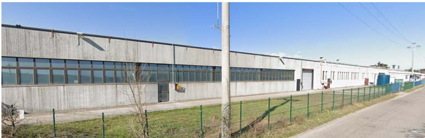
Lo stabilimento ANCAP – lato sud
