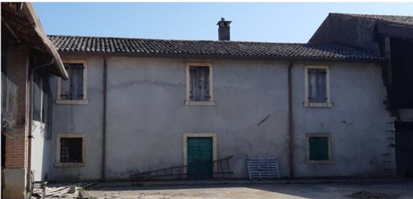
vista lato nord del corpo sud
