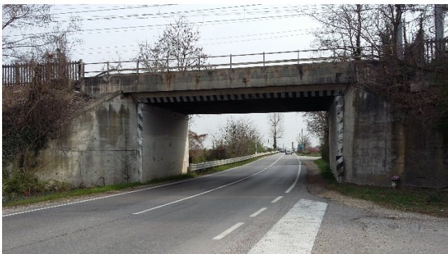
Foto 9 - Vista lato Nord Viadotto su S.P.26 "Morenica"
