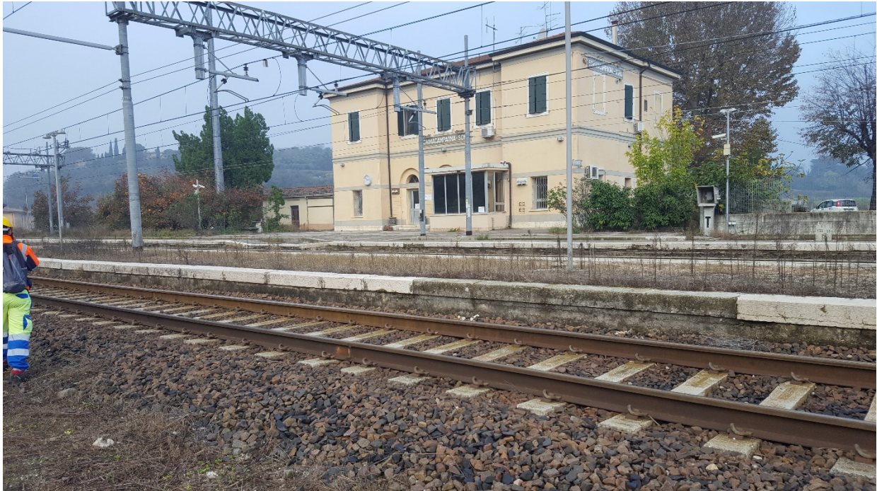
Foto 5 - Stazione Sommacampagna – Vista Fabbricato Viaggiatori pk 136+586
