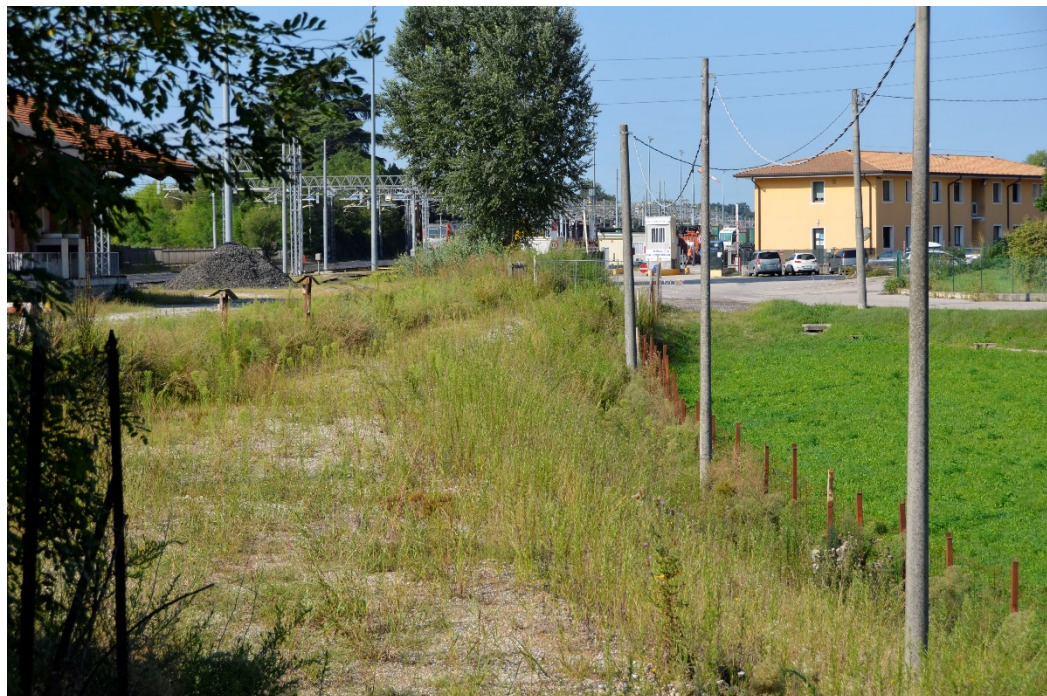
Foto 17 – Rilevato provvisorio adiacente asta di manvora scalo RBN
