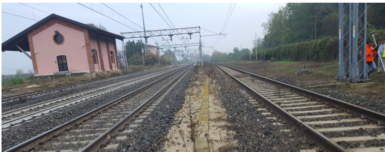
Foto 4 - Stazione Sommacampagna – Vista lato Brescia
