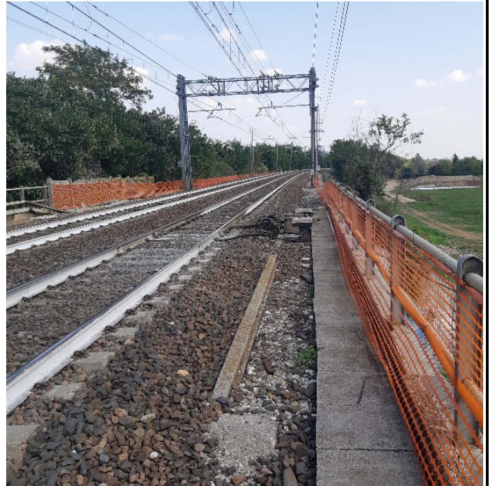
Foto 8 - Vista lato BS Viadotto su S.P.26 "Morenica"
