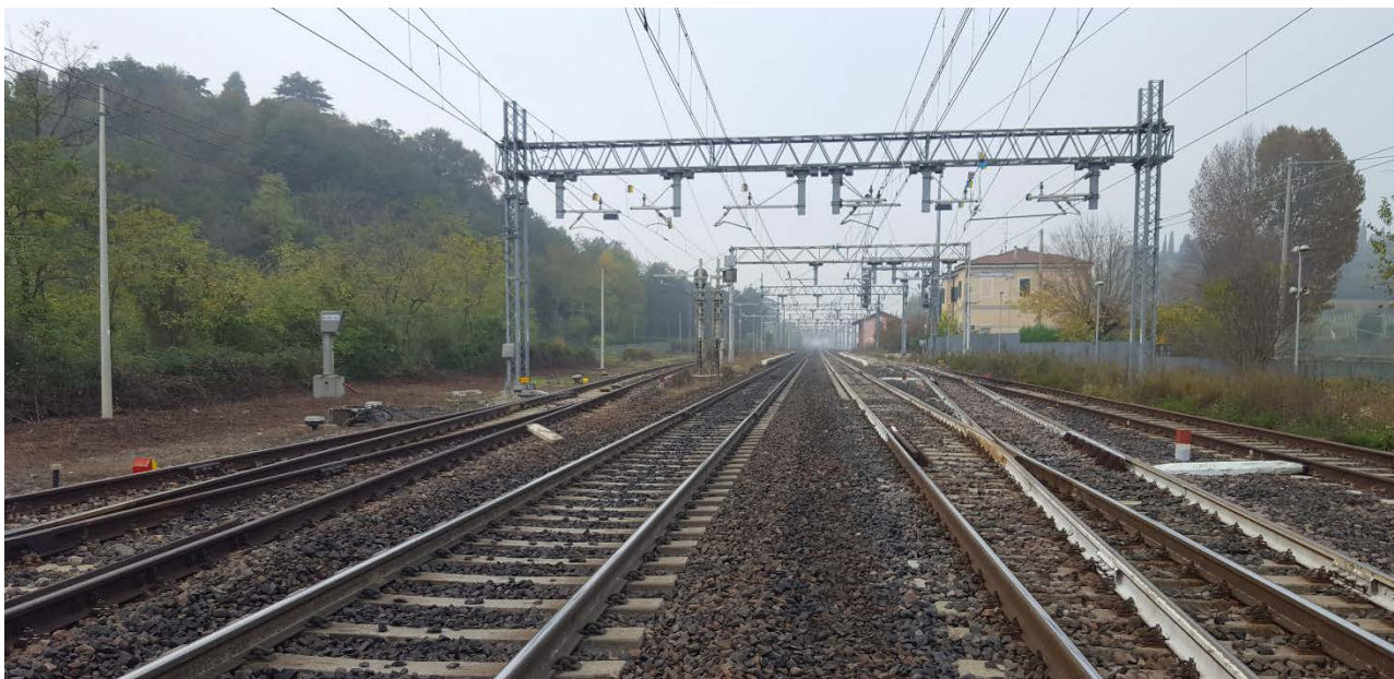
Foto 3 - Stazione Sommacampagna – Vista lato Verona
