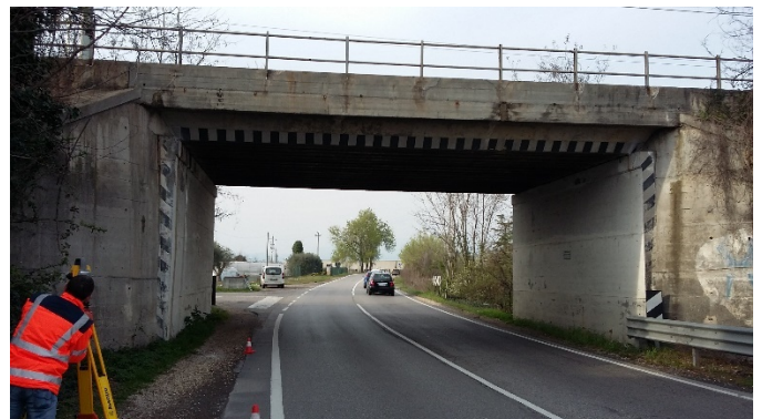
Foto 10 - Vista lato Sud Viadotto su S.P.26 "Morenica"
