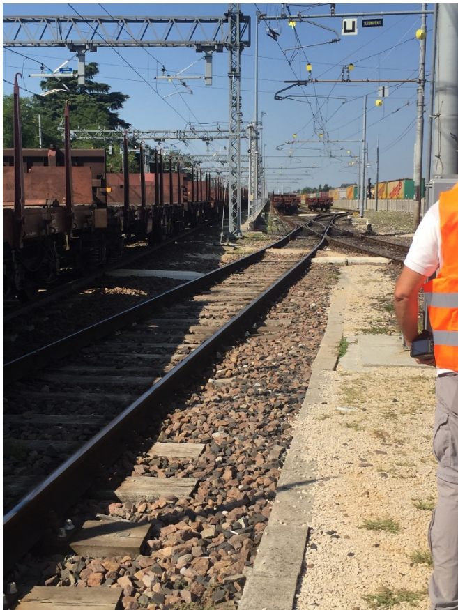
Foto 11 – Ingresso binari di Presa/Consegna scalo RBN
