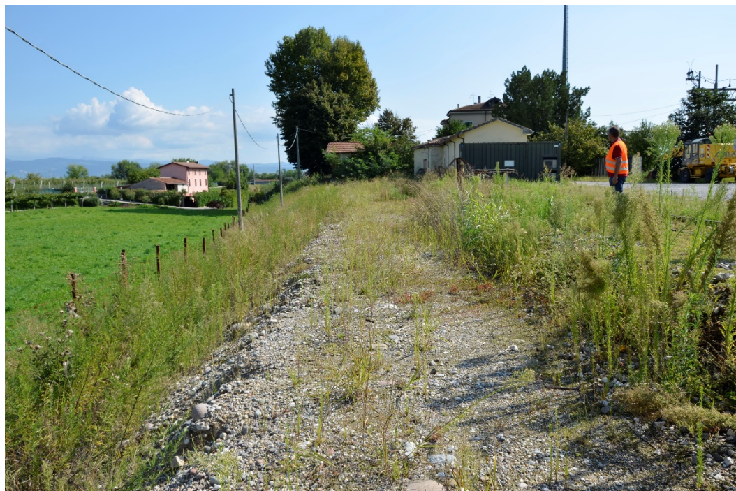
Foto 18 – Rilevato provvisorio adiacente asta di manovra scalo RBN
