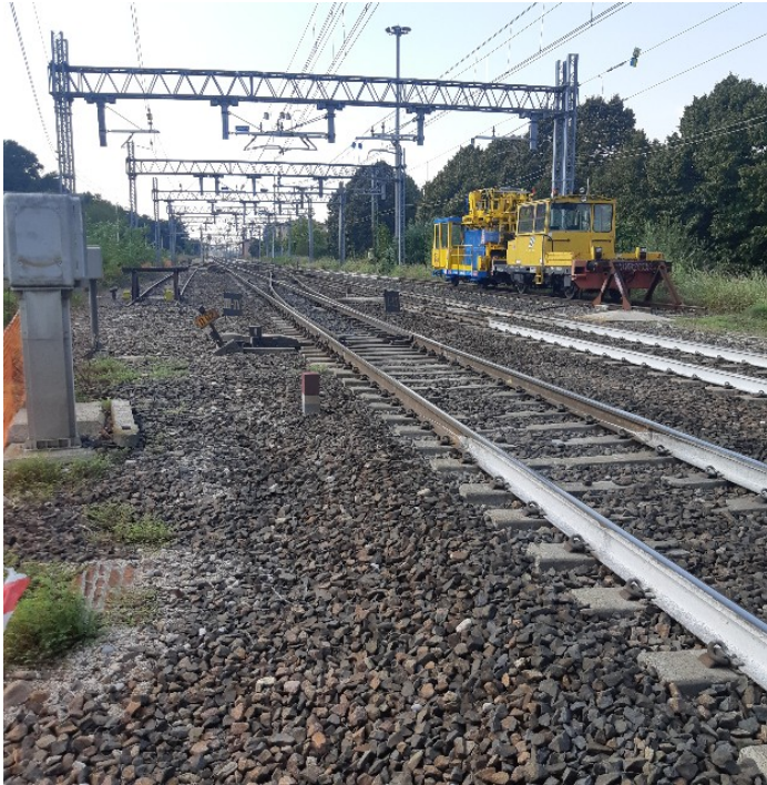
Foto 7 - Vista Lato Verona termine binari di precedenza
