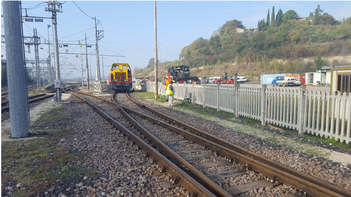
Foto 13 – Binario ingresso scalo RBN e radice asta di manovra
