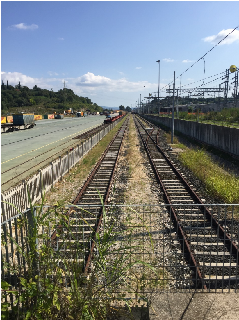
Foto 16 – Limite scalo RBN lato Brescia – Vista 3 binari P/C e muro di sostegno tra scalo e L.S.
