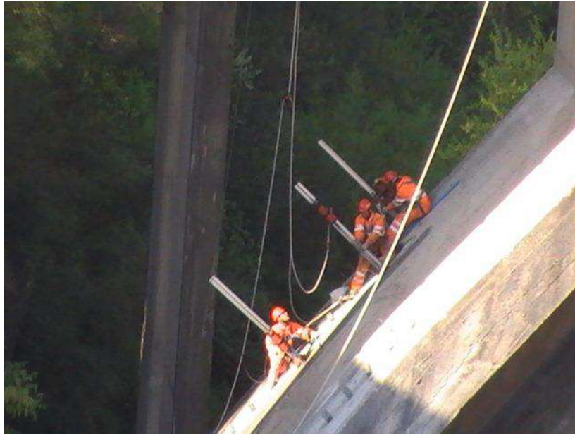
Perforazione a carotaggio
