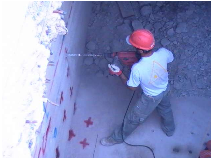
Perforazione con martello elettrico
